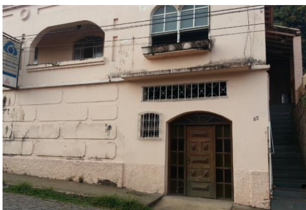
Figura 3 - Ouvidoria Geral: Avenida Rio Branco, 83
