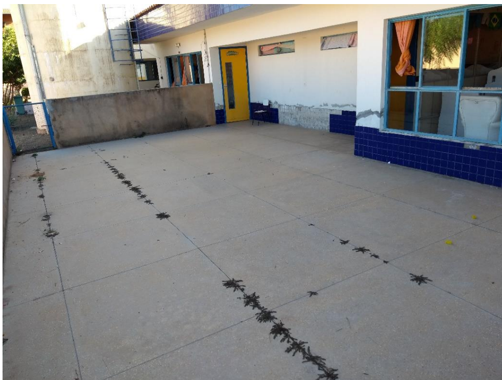
Figura 5 – Aspecto externo de pisos e paredes do CEMEI
