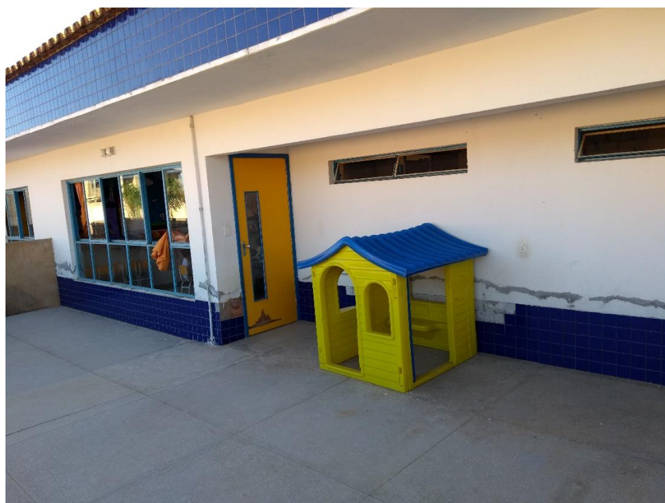
Figura 6 – Paredes sem recomposição de cerâmicas
