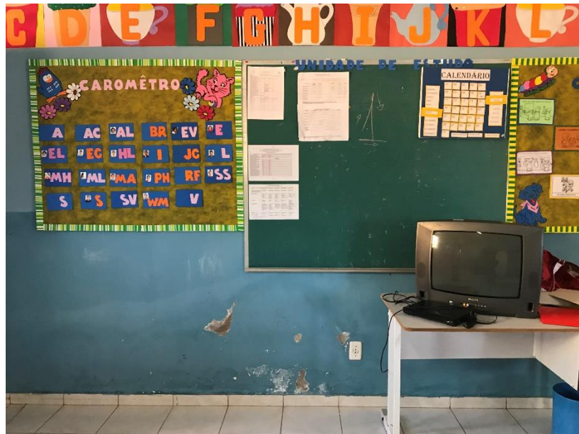
Figura 52 – Paredes descascadas
