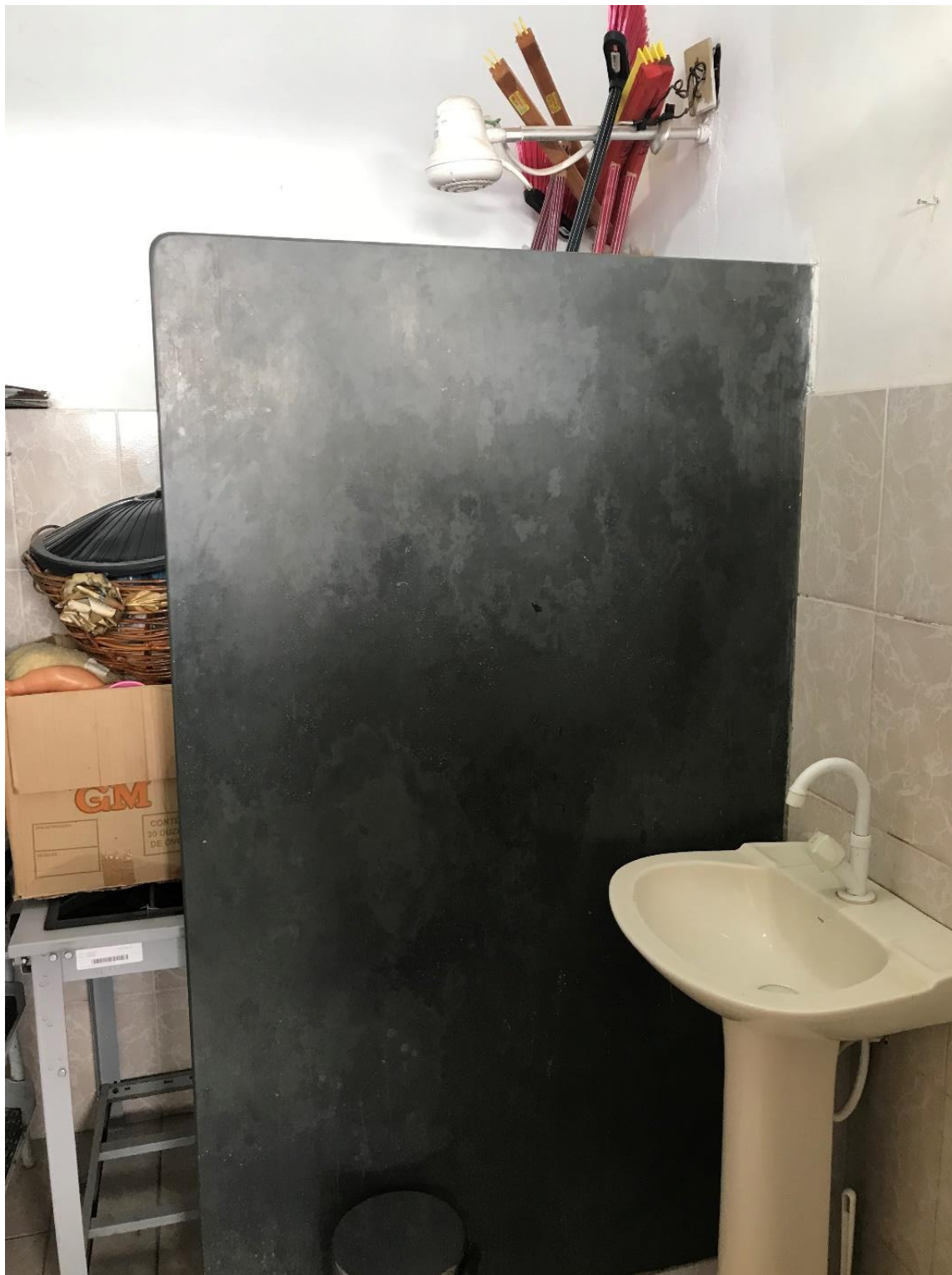
Figura 41 – Materiais armazenados no banheiro
