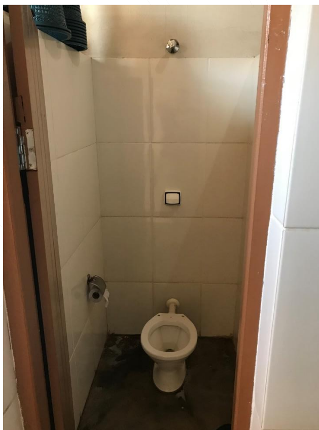
Figura 30 – Aspecto do piso do banheiro
