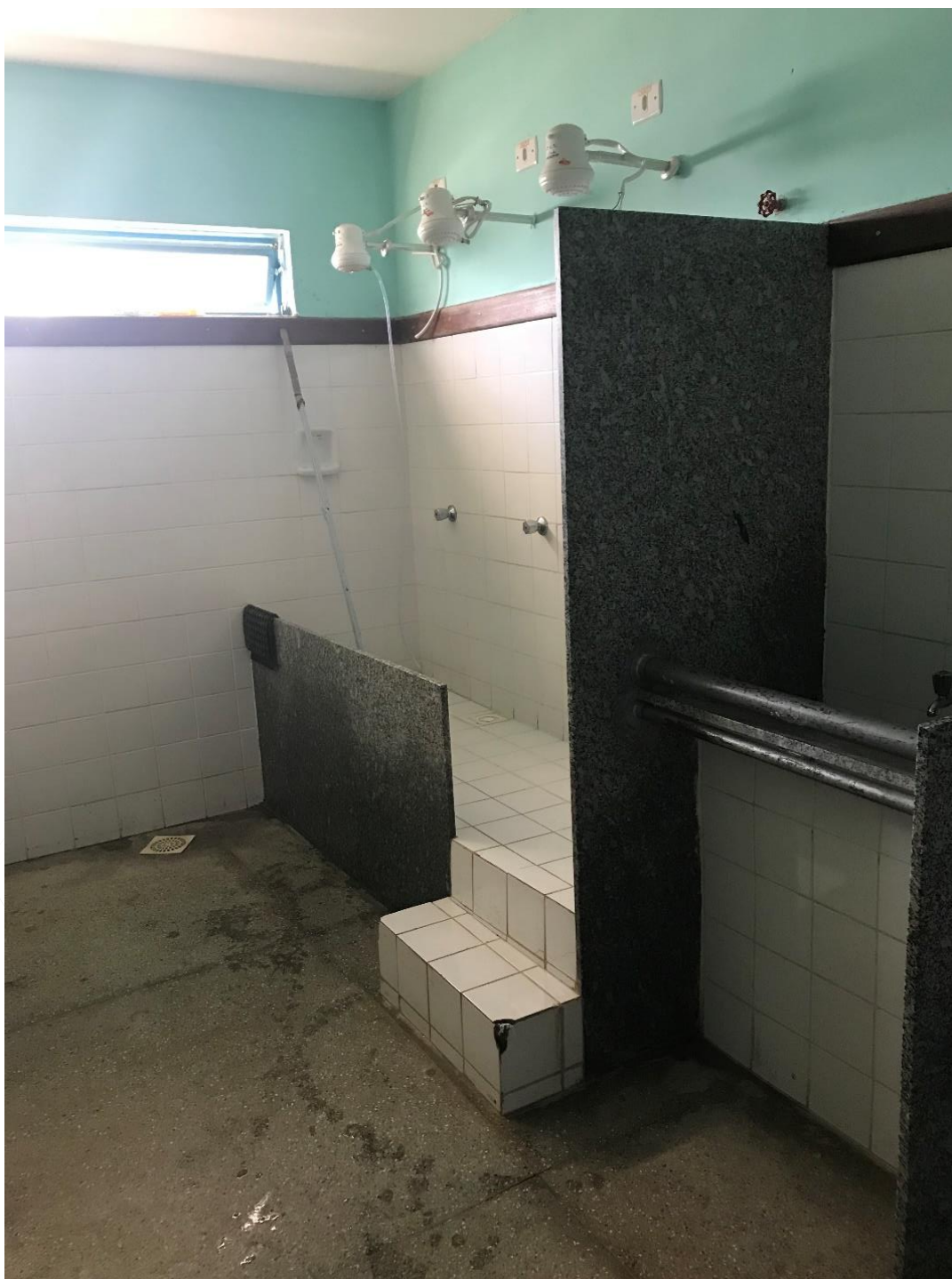
Figura 14 – Degraus revestidos em azulejo no banheiro das crianças
