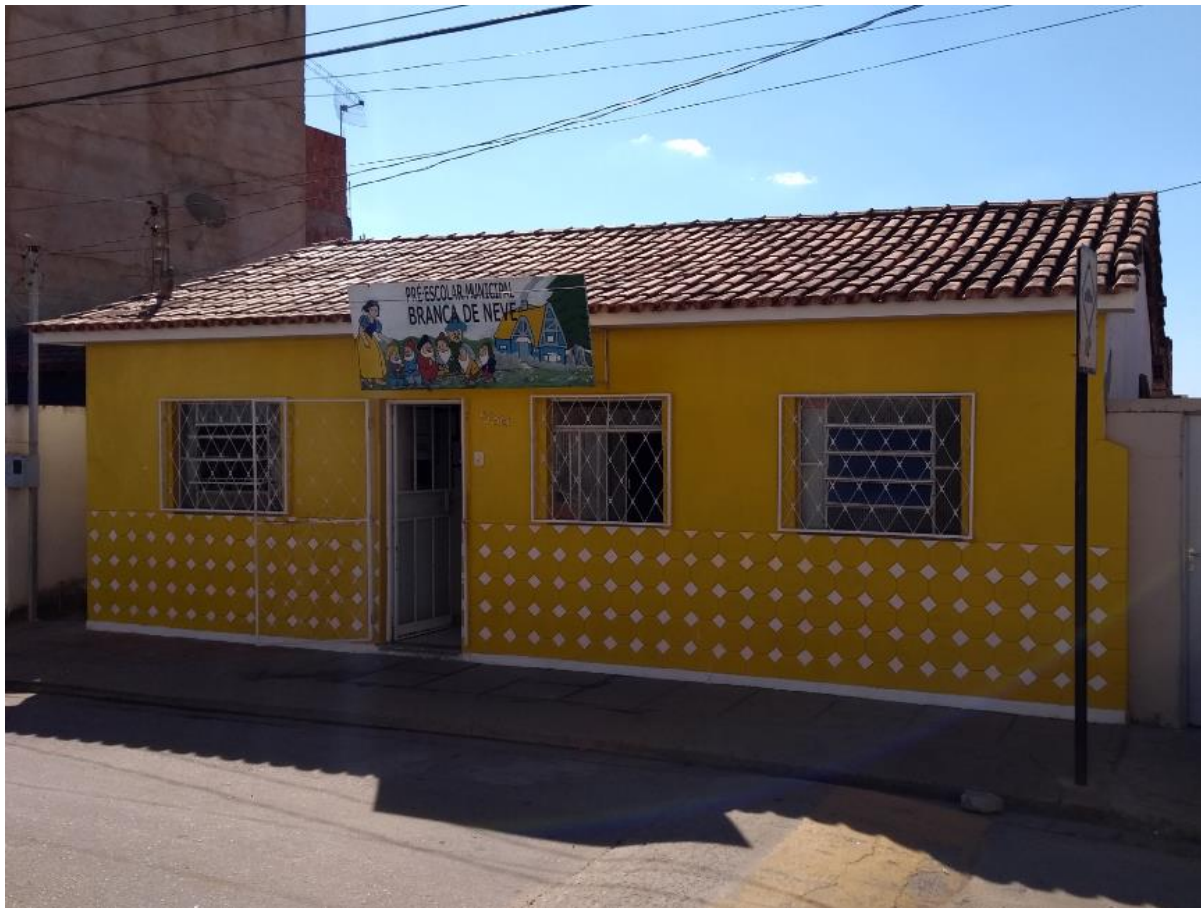
Figura 31 – Fachada do Pré-Escolar Municipal Branca de Neve
