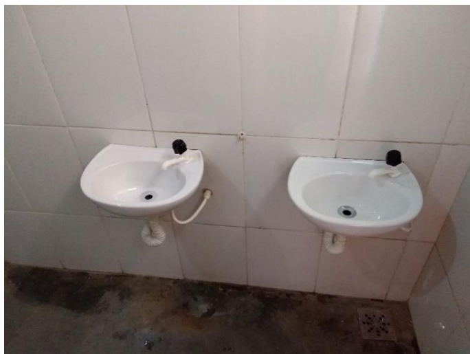
Figura 29 – Piso do banheiro infantil
