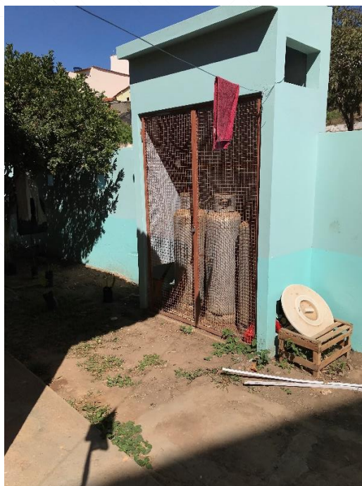
Figura 48 – Nicho com cilindros de gás
