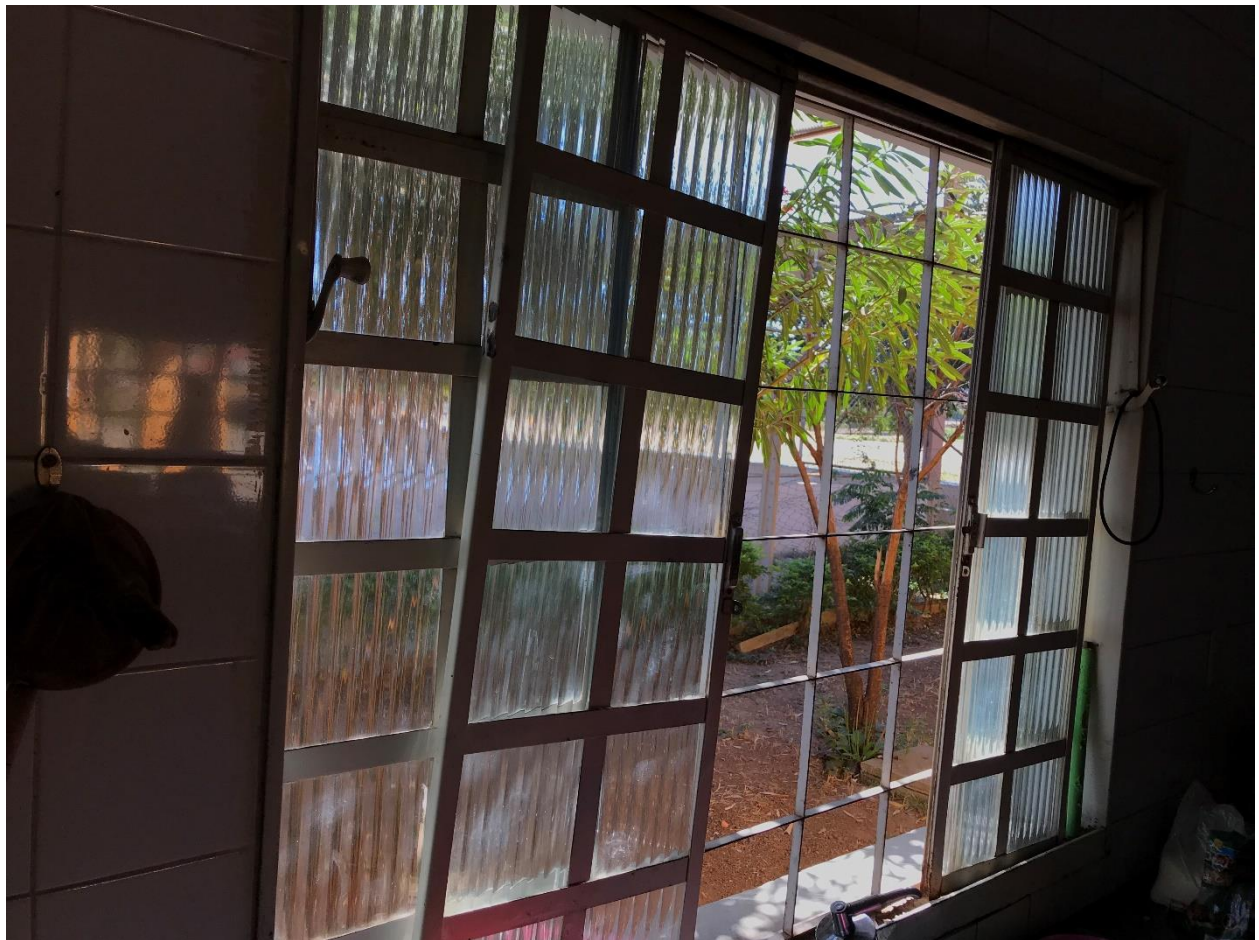
Figura 46 – Esquadrias da janela da cozinha
