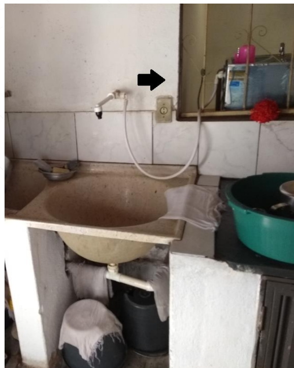
Figura 37 – Detalhe da instalação do bebedouro
