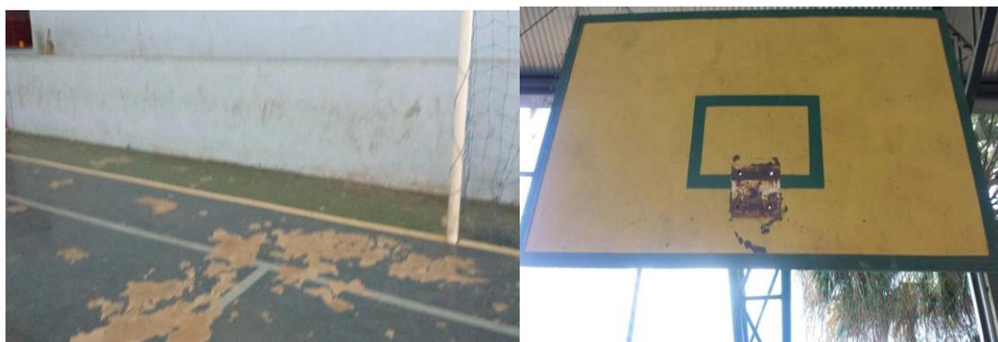
Figura 11: Fotos da EM Olinto Martins – Trabalho de campo em 13 e 14/11/2017 – Quadras de esporte sem manutenção com pisos descascados e equipamentos danificados.
