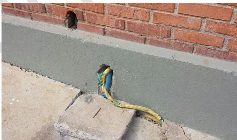
Figura 12: Fotos da EM Olinto Martins – Trabalho de campo em 13 e 14/11/2017 – Área externa com pisos danificados e fiação exposta.
