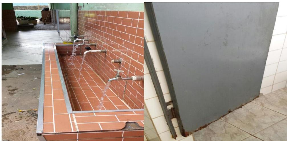
Figura 5: Fotos da EM Olinto Martins – Trabalho de campo em 13 e 14/11/2017 – Área externa com piso danificado e porta de sanitário danificada.
