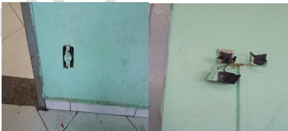
Figura 8: Fotos da EM Padre Alípio Martins e EM Olinto Martins – Trabalho de campo em 13 e 14/11/2017 – Salas de aula com fios e tomadas desprotegidas e em mal estado de conservação, armários enferrujados e portas de madeira bastante danificadas.
