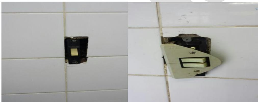
Figura 6: Fotos da EM EM Padre Alípio Martins Pinheiro e EM Olinto Martins – Trabalho de campo em 13 e 14/11/2017 – Área externa com fios expostos e/ou desencapados, tomadas e apagadores quebrados.
