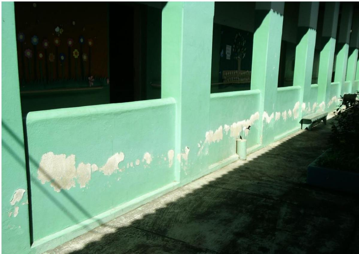
**Figura 7 - Paredes descascadas**
