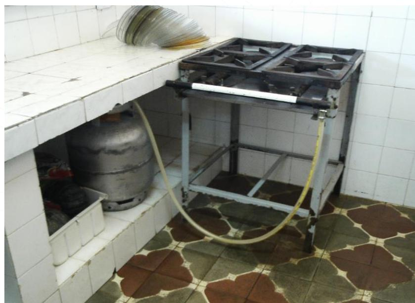
**Figura 13 - Botijões instalados e armazenados na cozinha da escola**
