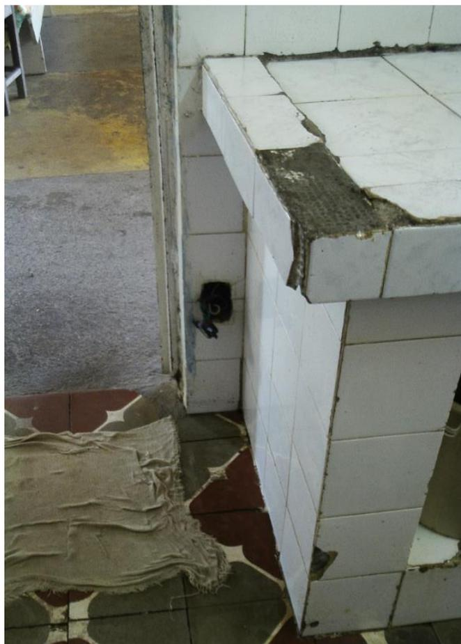
**Figura 14 - Bancada deteriorada**
