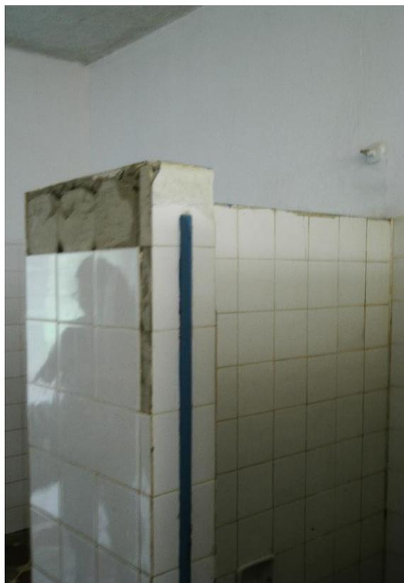
**Figura 17 - Ausência de revestimento em azulejo**
