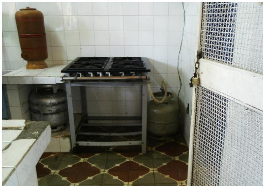
**Figura 12 - Botijões instalados e armazenados na cozinha da escola**
