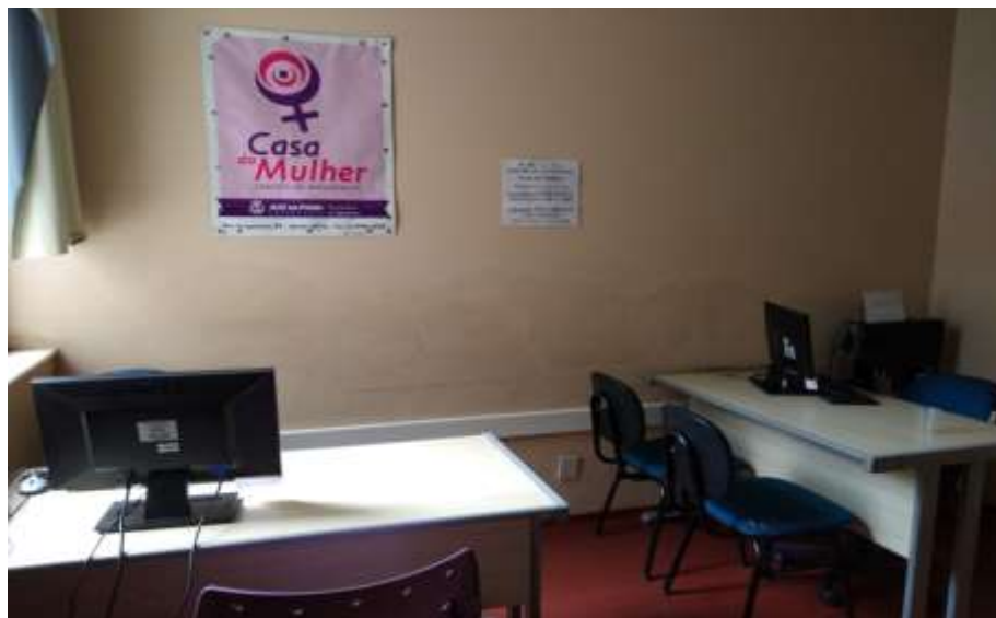
Figura 1: Infiltração na parede de uma das salas de atendimento da Casa da Mulher
