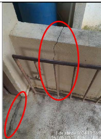
**Figura 46 - Detalhes de rachaduras no piso e mureta**
