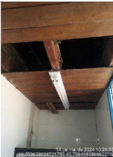
**Figura 120 - Detalhe da precariedade do forro de madeira do banheiro**
