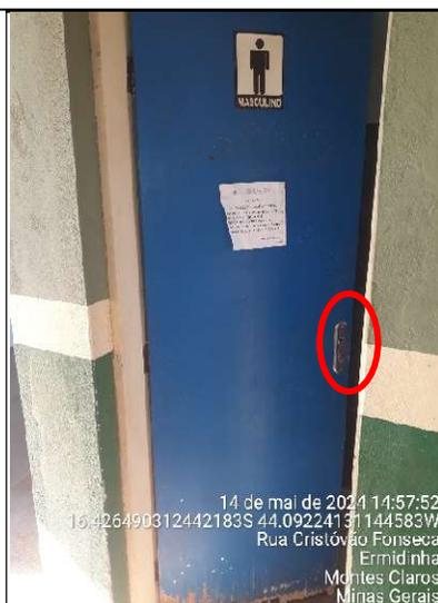
**Figura 93 - Detalhe da ausência de maçaneta na porta do banheiro masculino**
