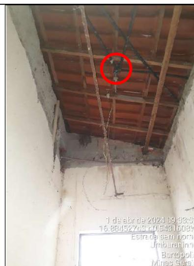
Figura 28 - Detalhes das ausências de forro e de lâmpada no banheiro
