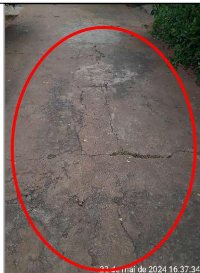
**Figura 305 – Detalhes de rachaduras na rampa de acesso à escola, lado interno**
