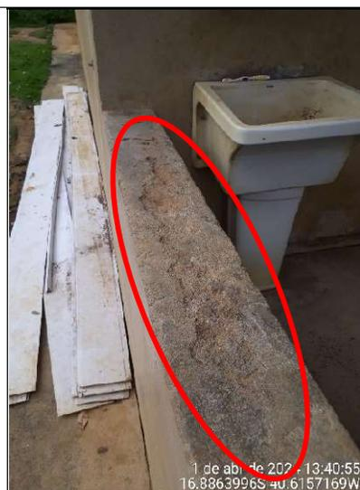
**Figura 50 - Detalhe de desgaste de revestimento na face superior da mureta**
