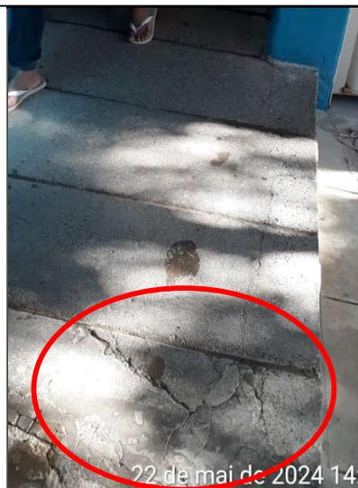
**Figura 332 – Detalhe de rachaduras no piso da rampa**
