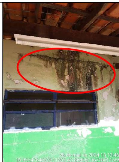
**Figura 149 - Detalhe de infiltrações na parede, lado externo**
