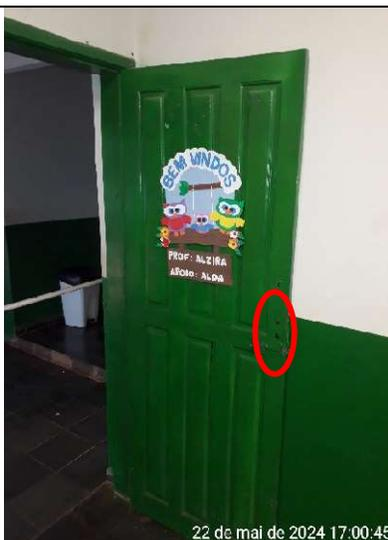
**Figura 315 – Detalhe da porta da sala de aula sem maçaneta e fechadura**
