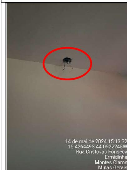
**Figura 95 - Detalhe de cabo elétrico aparente de ponto de luz sem lâmpada**
