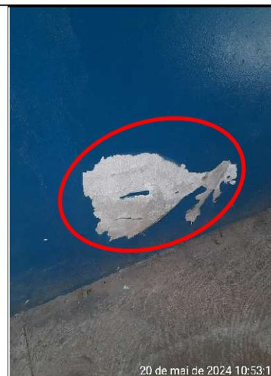
Figura 292 – Detalhe de desgaste da pintura da parede, lado externo
