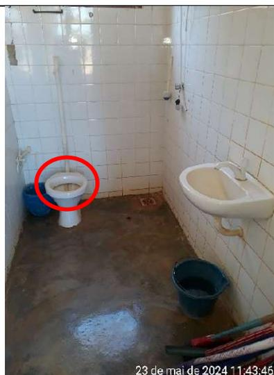
**Figura 374 – Detalhe da ausência de assento na bacia sanitária**
