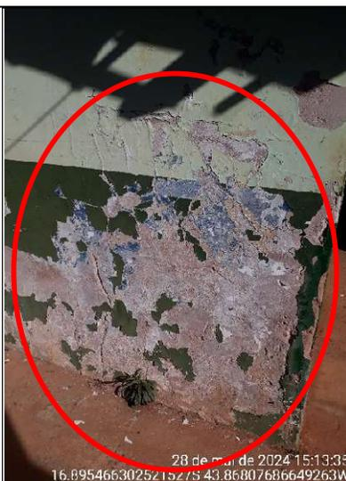
**Figura 150 - Detalhes de problemas na pintura e revestimento da parede, lado externo**
