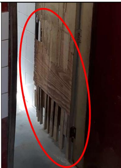
**Figura 402 – Detalhe da situação precária da porta de madeira do banheiro**
