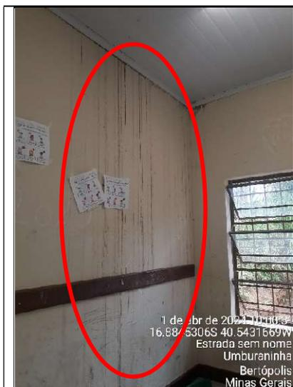
Figura 23 - Detalhe de manchas de infiltração na parede da sala de aula
