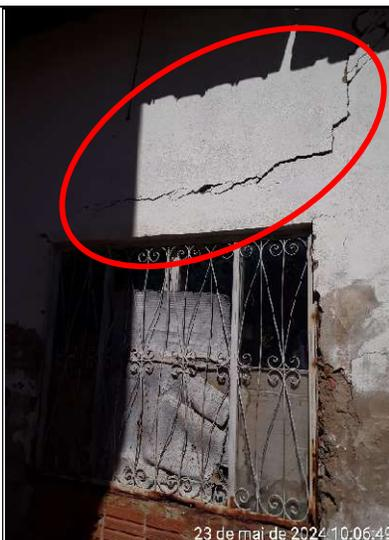
Figura 390 – Detalhe de rachadura na parede, lado externo
