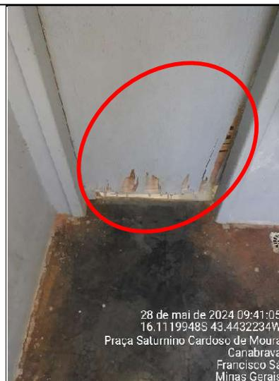
**Figura 433 – Detalhe de problema de umidade na porta do banheiro**
