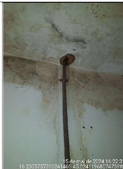
**Figura 247 - Detalhes das manchas de infiltração na laje e parede do banheiro feminino**
