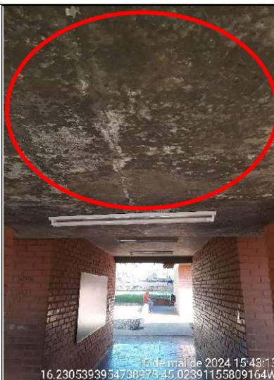
**Figura 246 – Detalhe de manchas de infiltração na laje da corredor**
