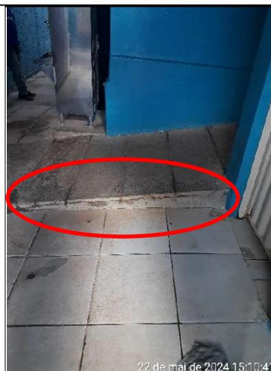
**Figura 331 – Detalhe de trecho final da rampa sem proteção**
