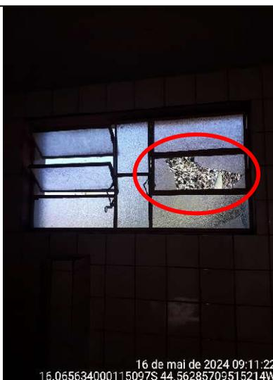
**Figura 198 – Detalhe da janela do banheiro masculino com vidro quebrado**
