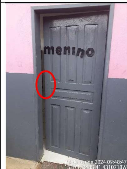
**Figura 74 - Detalhe da ausência de maçaneta na porta do banheiro masculino**
