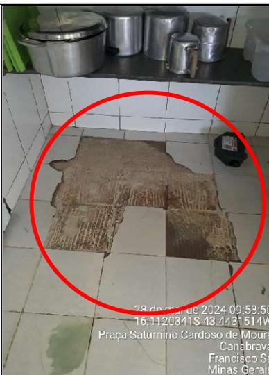
**Figura 429 – Detalhes de pisos quebrados e descolamento de pisos na cozinha**
