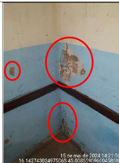
Figura 214 - Detalhe do desgaste da pintura da parede da sala de aula
