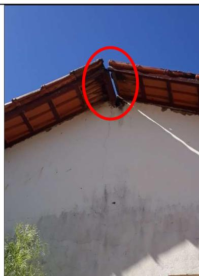
**Figura 406 – Detalhe da ausência de cumeeira na cobertura**
