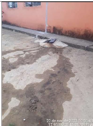
**Figura 11 - Detalhe de transbordamento de efluente de esgoto da caixa de gordura**
