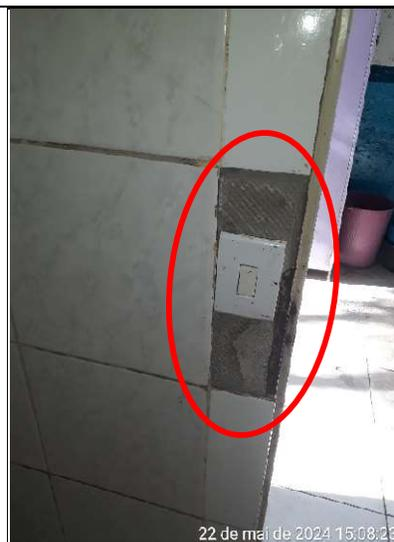
**Figura 334 – Detalhe de trecho sem azulejos na parede do banheiro**
