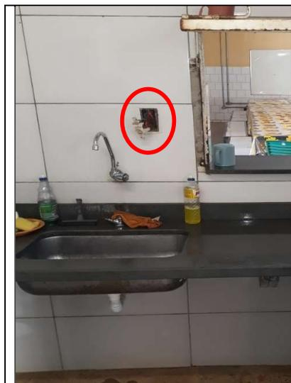
**Figura 221 – Detalhe de cabos elétricos aparentes**
