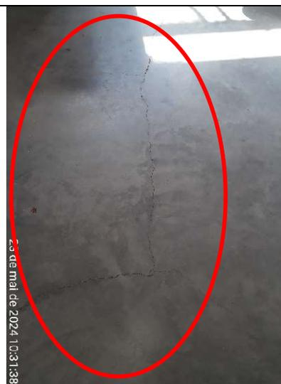
**Figura 382 – Detalhes de rachaduras no piso da sala de aula**
