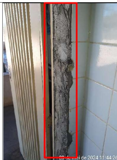
**Figura 364 – Detalhe da falta de acabamento da argamassa da parede do banheiro**
