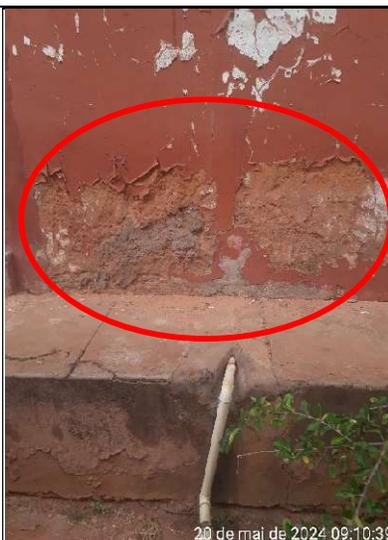
**Figura 270 – Detalhes de problemas no revestimento e pintura da parede, lado externo**
