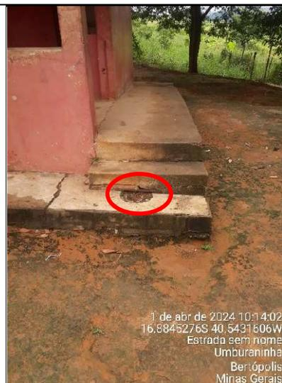
**Figura 17 – Detalhes dos degraus da calçada e escada para acesso à escola, com destaque para o buraco na calçada**
