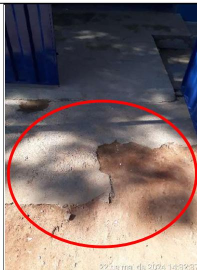
**Figura 328 – Detalhe de trecho quebrado da calçada de acesso à escola, lado externo**
