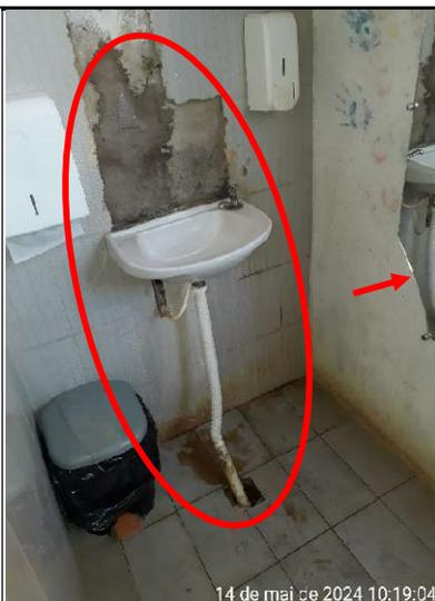
Figura 129 - Detalhe da precariedade das condições de uso do banheiro
