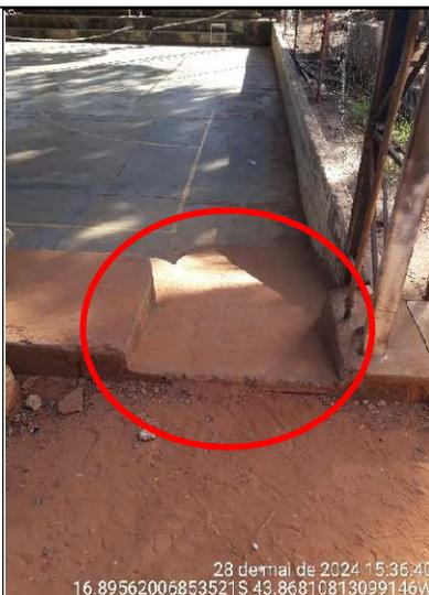
**Figura 141 - Detalhe das ausências de guarda-corpo e corrimão na rampa de acesso à quadra poliesportiva**
