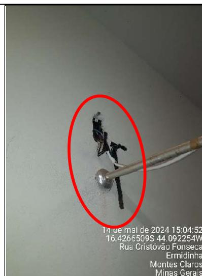
**Figura 94 - Detalhe de cabo elétrico aparente e com remendo**
