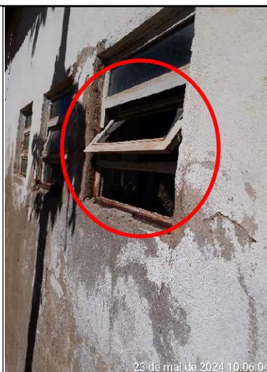
**Figura 405 – Detalhes da janela do banheiro: um vão sem vidro e outro com vidro quebrado**
