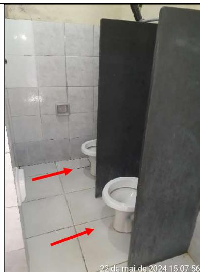
**Figura 338 – Detalhes das bacias sanitárias sem assentos e boxes sem portas**
