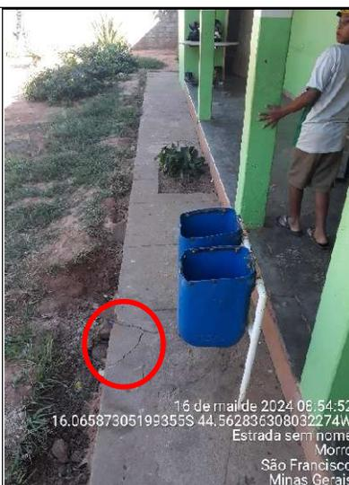
**Figura 177 - Detalhe de rachadura na calçada**
