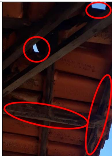
**Figura 121 - Detalhes de problemas no beiral da cobertura, com detalhes dos cupins no madeiramento**
