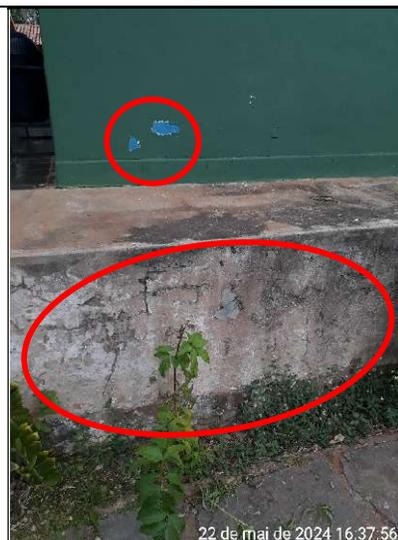
**Figura 314 – Detalhe de desgaste da pintura, lado externo**
