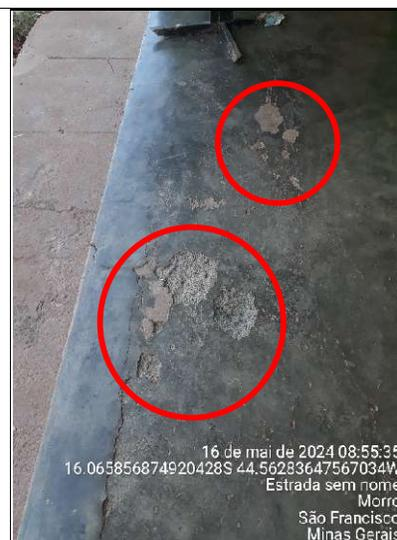
**Figura 178 - Detalhes de buracos no piso do pátio**
