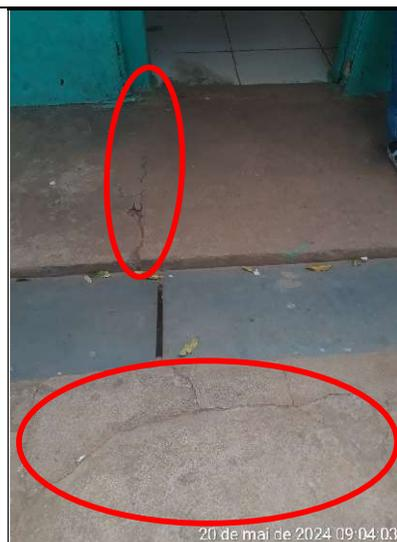
**Figura 260 – Detalhes de trincas e rachadura na calçada**
