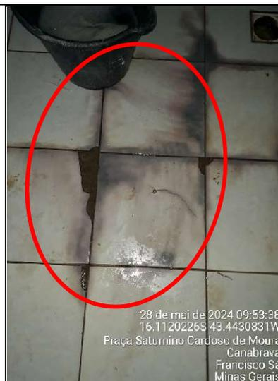
**Figura 427 – Detalhes de pisos quebrados e manchados na cozinha**
