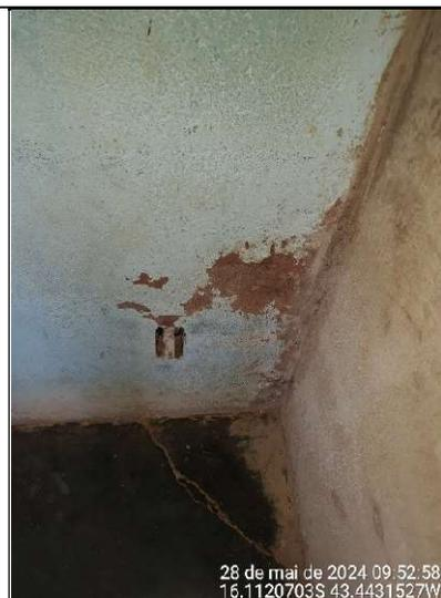
**Figura 431 – Detalhe da sujeira e falta de pintura na parede da despensa**
