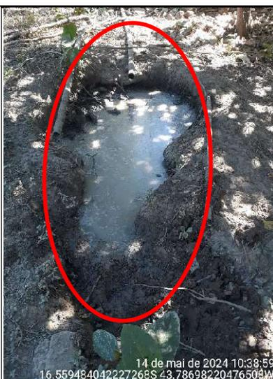
Figura 132 – Detalhe do lançamento do efluente de esgoto da cozinha diretamente no solo, devido à ausência de caixa de gordura
