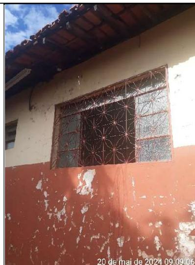
**Figura 269 – Detalhe de desgaste da pintura da parede, lado externo**
