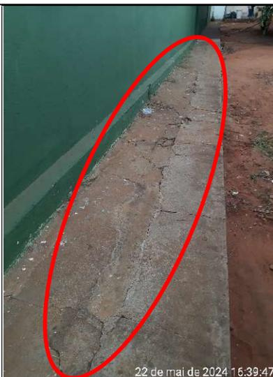
**Figura 306 – Detalhes de rachaduras na calçada perimetral**
