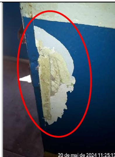
Figura 295 – Detalhe de desgaste da pintura da parede da sala de aula...
