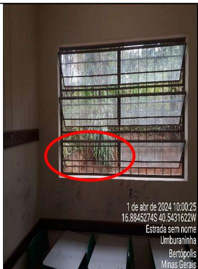
**Figura 32 - Detalhe da janela da sala de aula com vão sem vidro**
