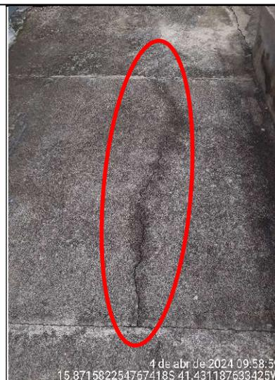
**Figura 67 - Detalhe de rachadura na calçada, lado interno**
