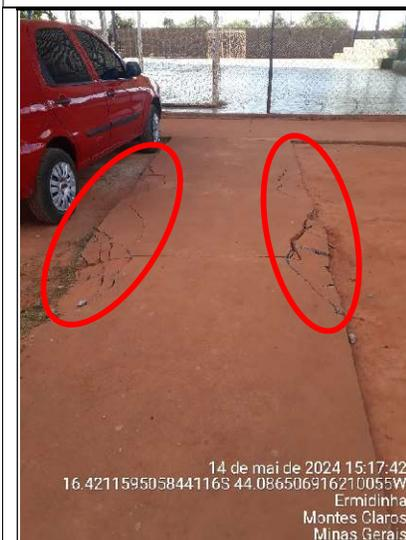
Figura 83 - Detalhes de trechos quebrados da calçada de acesso à quadra
