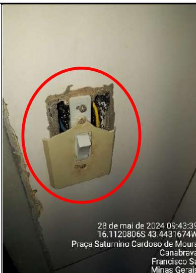
**Figura 438 – Detalhe de cabo elétrico aparente devido ao espelho da tomada quebrado**
