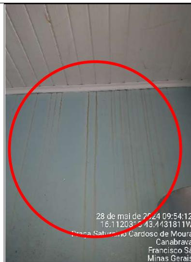
**Figura 436 – Detalhe de manchas de infiltrações na parede da cozinha**
