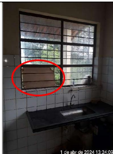
Figura 53 - Detalhe da janela da cozinha com vão sem vidro
