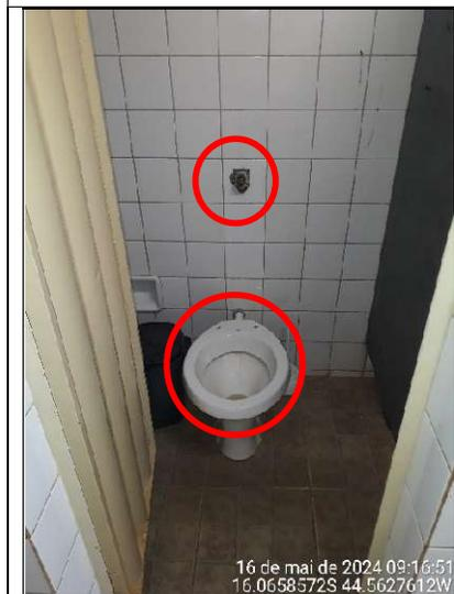
**Figura 194 - Detalhes das ausências de assento na bacia sanitária e do acabamento da válvula de descarga**
