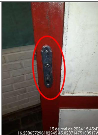
**Figura 252 - Detalhe da ausência de maçaneta na porta da sala de aula**
