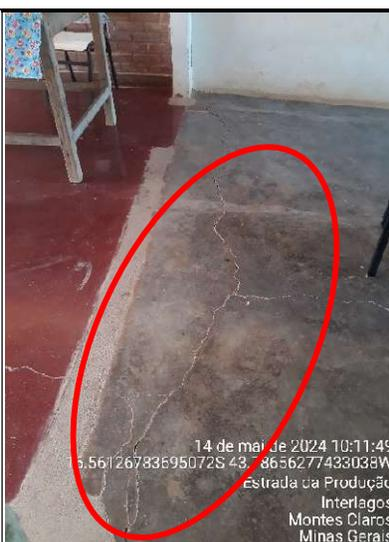
**Figura 108 - Detalhe de rachaduras no piso da varanda externa...**
