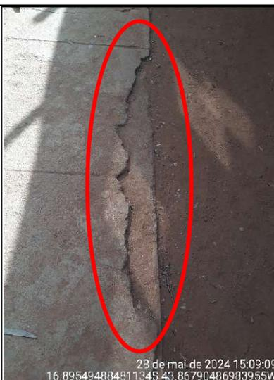
**Figura 138 - Detalhe de trecho quebrado da borda da calçada perimetral**
