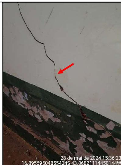
**Figura 152 – Detalhe de rachadura na parede, lado externo**
