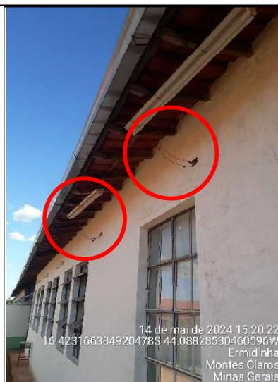
**Figura 96 - Detalhes de cabos elétricos aparentes e com remendos, lado externo**
