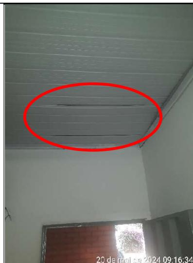
Figura 281 – Detalhe do deslocamento do forro de PVC da sala de aula devido a infiltração
