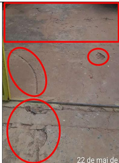
**Figura 304 – Detalhes de buracos e rachaduras na rampa de acesso à escola, lados externo e interno**
