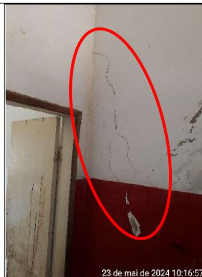
Figura 394 – Detalhes de rachaduras na parede do banheiro
