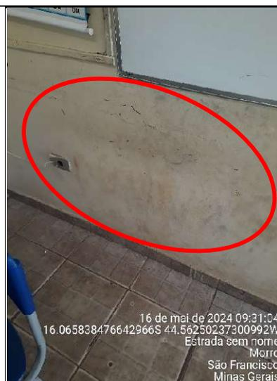
**Figura 187 - Detalhe do desgaste da pintura da parede da sala de aula**
