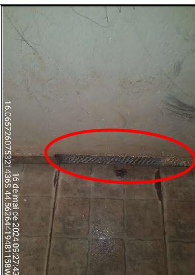
Figura 183 - Detalhe do descolamento do rodapé da sala de aula
