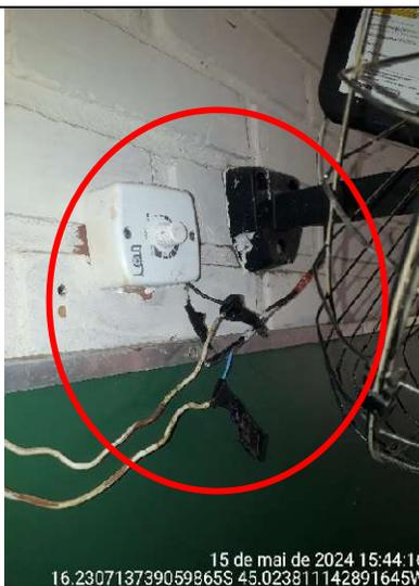
Figura 237 – Detalhes de cabos elétricos aparentes e com remendos na sala de aula
