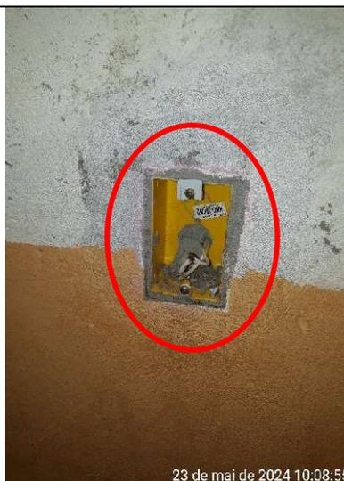
Figura 411 - Detalhe de cabo elétrico aparente devido ausência de espelho da caixa
