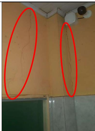
**Figura 268 – Detalhes de trinca e rachadura na parede da cozinha**
