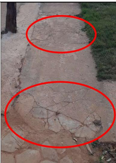
**Figura 420 – Detalhe de rachaduras na rampa lateral de acesso à escola, lado externo**
