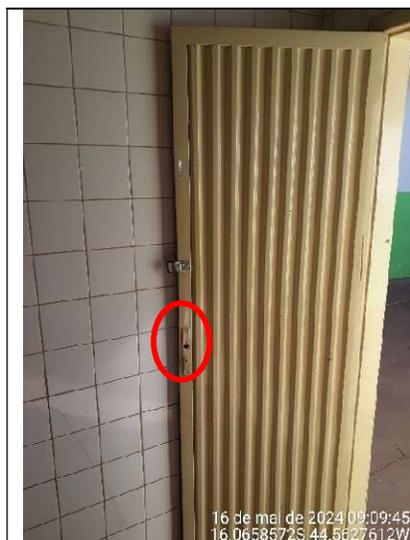
**Figura 197 – Detalhe de ausência de maçaneta na porta do banheiro masculino**
