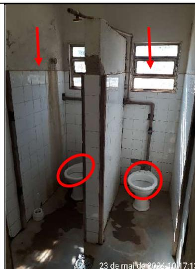
**Figura 403 – Detalhes das ausências: das portas dos boxes do banheiro e dos assentos das bacias sanitárias**
