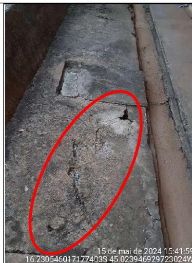
Figura 229 - Detalhes das rachaduras e buracos na calçada
