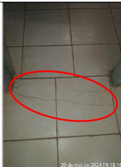
**Figura 265 – Detalhe de trincas no pisos da sala de aula**
