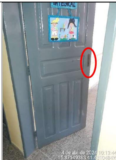
**Figura 72 - Detalhe da ausência de maçaneta na porta da sala de aula**
