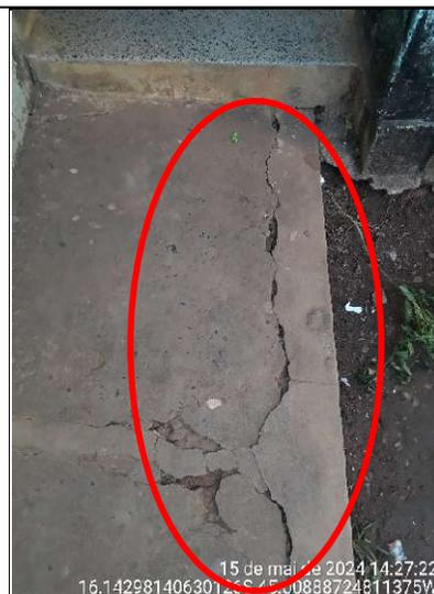
**Figura 205 - Detalhe de rachaduras na calçada de acesso à sala de aula**
