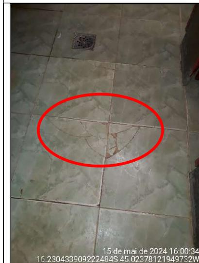
**Figura 233 - Detalhe dos pisos quebrados no banheiro feminino**
