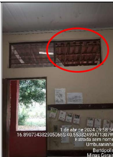
**Figura 30 - Detalhe da janela da sala de aula com vidro danificado**
