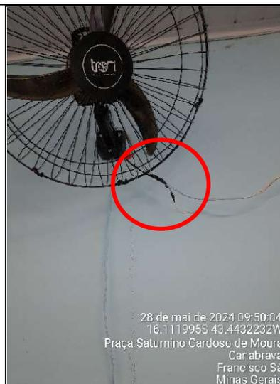
**Figura 439 – Detalhe de cabo elétrico aparente e com remendo**
