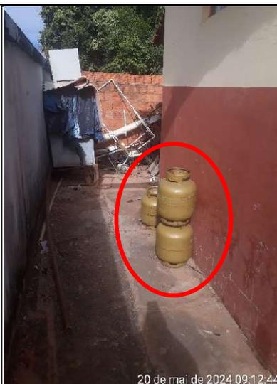
Figura 282 – Detalhe do local de armazenamento de botijões de GLP, em local descoberto
