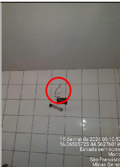
**Figura 195 - Detalhe de cabos elétricos aparentes**
