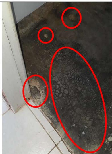
**Figura 430 – Detalhes de manchas, fissuras e buracos no piso da despensa**
