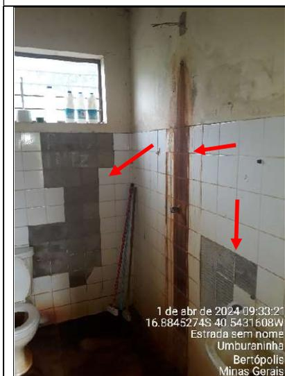
Figura 26 - Detalhes de mancha e trechos sem azulejos na parede do banheiro
