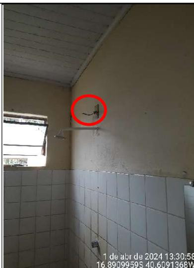
Figura 60 - Detalhe de cabo elétrico aparente e com remendo
