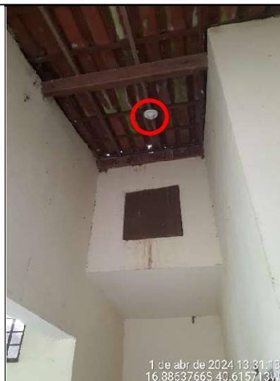
Figura 59 - Detalhe de ponto de luz sem lâmpada
