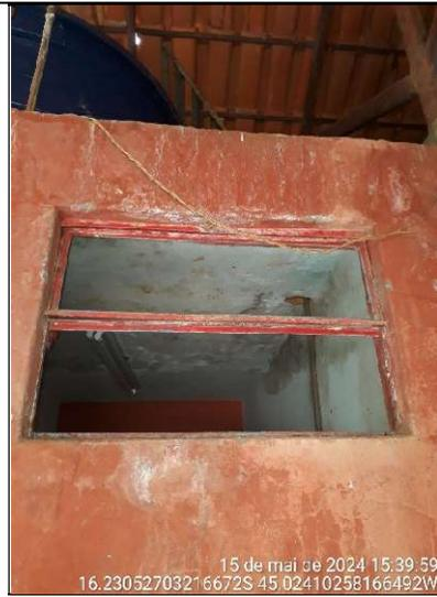
**Figura 248 – Detalhe da janela do banheiro sem vidros**
