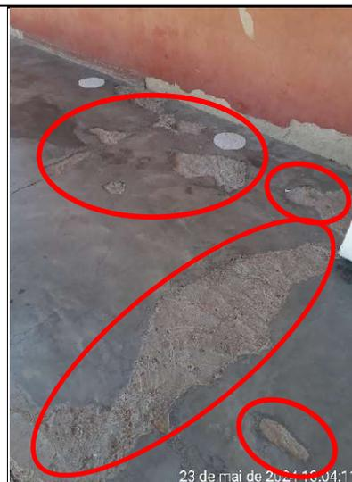
**Figura 379 – Detalhes de buracos e remendos no piso da varanda**
