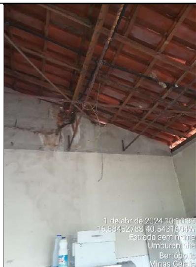
**Figura 29 - Detalhe da ausência de forro na cozinha**
