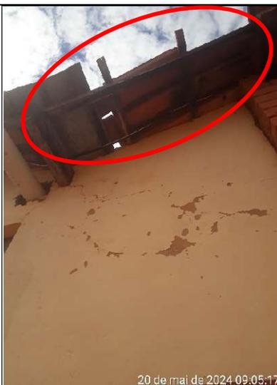
Figura 279 – Detalhe de problemas no madeiramento e telhas do beiral da cobertura
