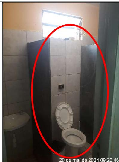
Figura 275 – Detalhe de ausência de porta no box do banheiro feminino
