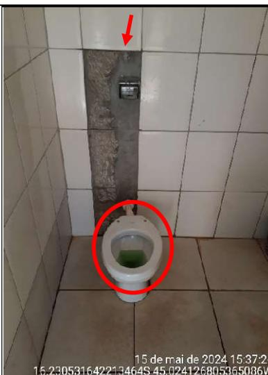
Figura 240 - Detalhes do descolamento de azulejos e ausência de assento na bacia sanitária no banheiro masculino
