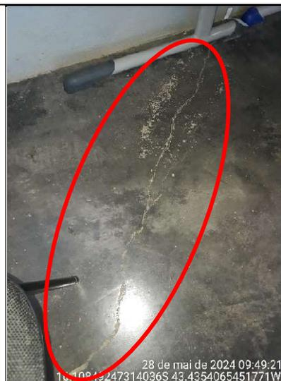
**Figura 425 – Detalhes de rachaduras e manchas no piso da sala de aula**
