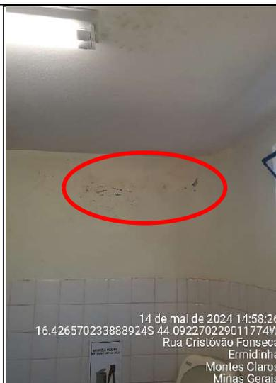
**Figura 87 - Detalhe de manchas de umidade na parede do banheiro**
