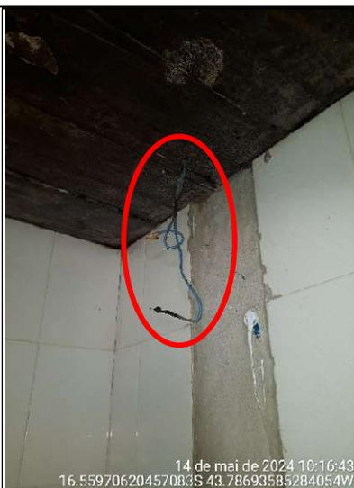
**Figura 126 - Detalhe de cabo elétrico aparente e com remendo...**
