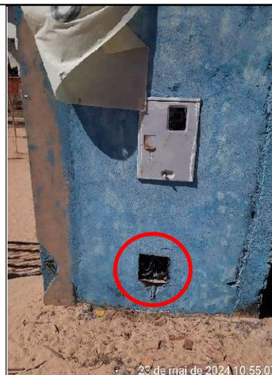
Figura 409 - Detalhe de cabos elétricos aparentes na mureta de entrada de energia da escola
