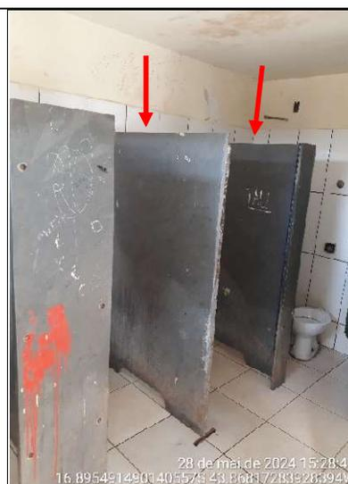
**Figura 157 – Detalhes das ausências das portas dos boxes do banheiro**
