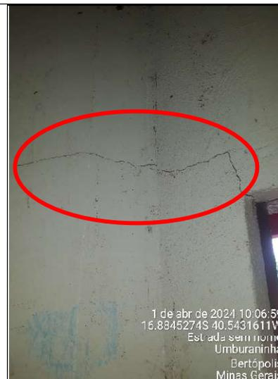
**Figura 22 - Detalhe de rachadura na parede do banheiro, lado interno**
