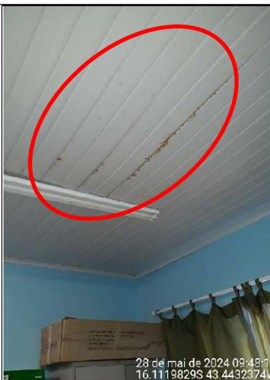
**Figura 435 – Detalhe de manchas de infiltrações no forro da sala de aula**
