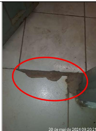
**Figura 263 – Detalhes de pisos quebrados na entrada do banheiro masculino**
