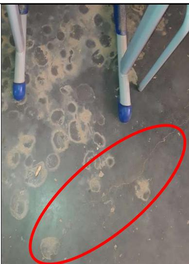
**Figura 351 – Detalhes de trinca e manchas no piso da sala de aula**
