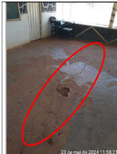
**Figura 353 – Detalhes de buracos e rachaduras no piso da sala de aula externa**
