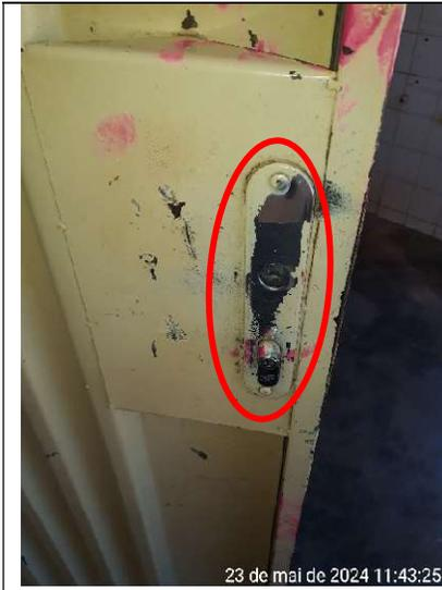
Figura 365 – Detalhe da porta do banheiro sem maçaneta
