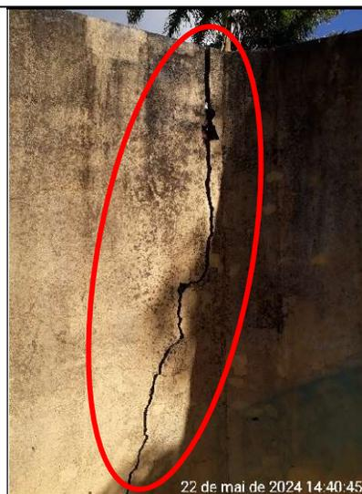
**Figura 335 – Detalhe de rachadura no muro de divisa**
