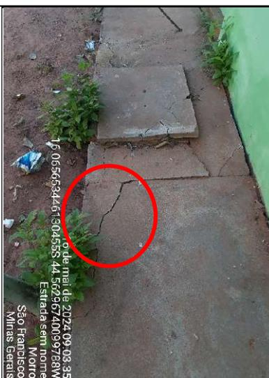
Figura 180 - Detalhe de rachadura na calçada...
