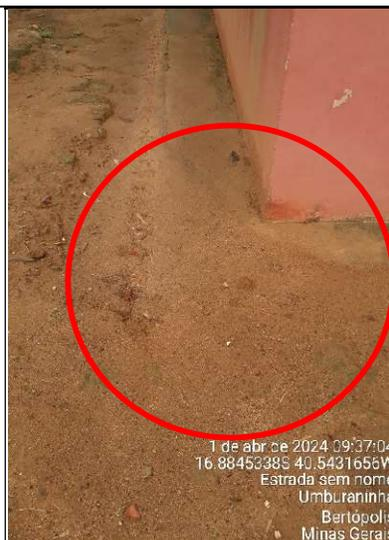
**Figura 18 – Detalhe de trecho da calçada coberto por terra**
