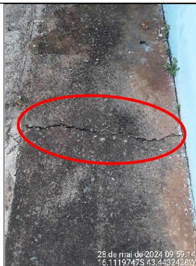
**Figura 422 – Detalhe de rachadura na calçada, lado interno da escola**
