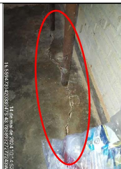
**Figura 109 - Detalhe de rachadura no piso da despensa de alimentos**
