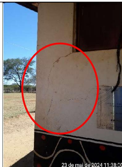
**Figura 355 – Detalhes de rachaduras na parede frontal**
