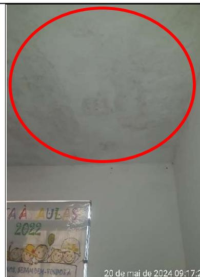
Figura 280 – Detalhe de manchas de infiltração na laje da sala de aula
