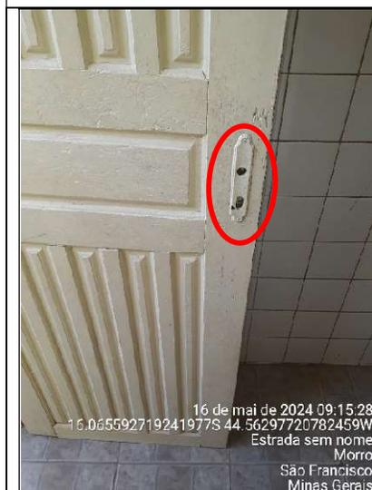
**Figura 200 – Detalhe da porta do banheiro feminino sem maçaneta**
