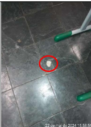
**Figura 309 – Detalhe de buraco no piso da sala de aula**
