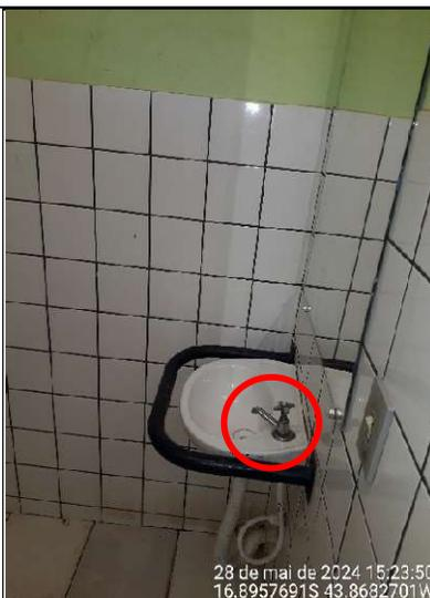
**Figura 165 – Detalhe da ausência de acabamento de metal para acionamento da torneira do lavatório para PcD**
