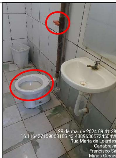
**Figura 440 – Detalhes das ausências de assento na bacia sanitária e da válvula de descarga**
