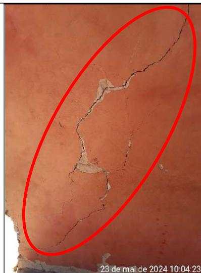
**Figura 386 – Detalhe de rachadura na parede, lado externo**
