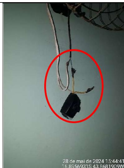
**Figura 167 – Detalhe de cabos elétricos aparentes e com remendos**
