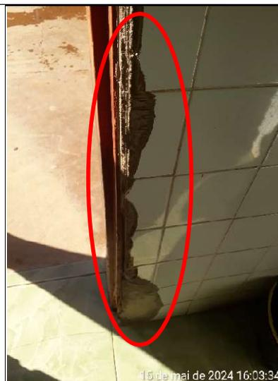
**Figura 235 - Detalhe de problema no revestimento do banheiro feminino**
