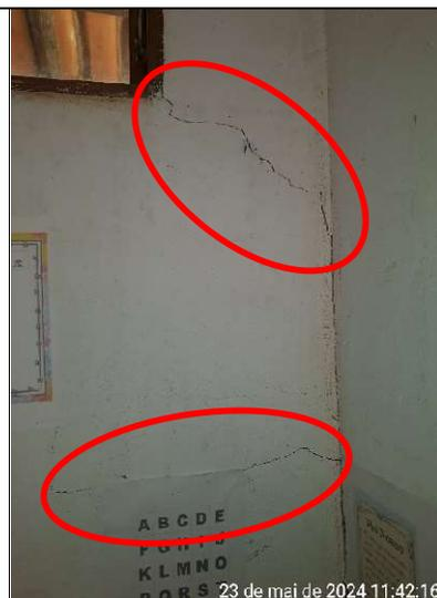
**Figura 358 – Detalhes de rachaduras na parede da sala de aula**
