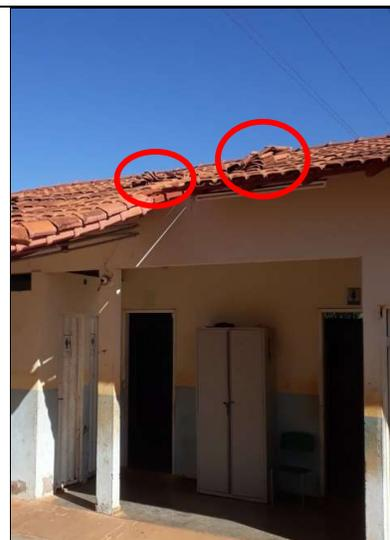
**Figura 217 - Detalhe de telhas soltas na cobertura**
