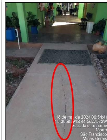
**Figura 176 - Detalhe de rachadura na calçada de acesso à escola**
