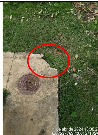
**Figura 43 - Detalhe de trecho quebrado da calçada**
