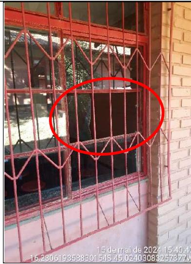
**Figura 249 – Detalhe da janela da sala de aula sem vidro**
