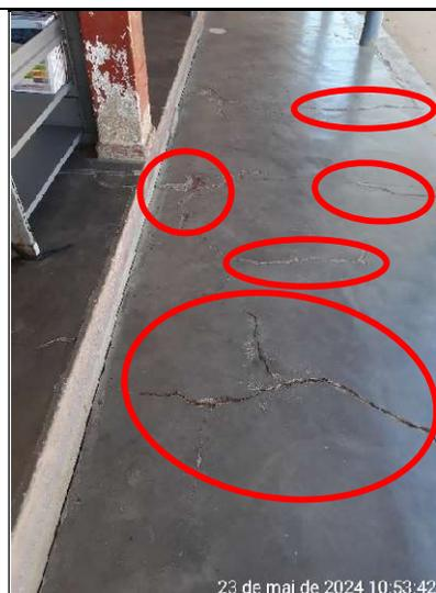
**Figura 380 – Detalhes de rachaduras no piso da varanda**
