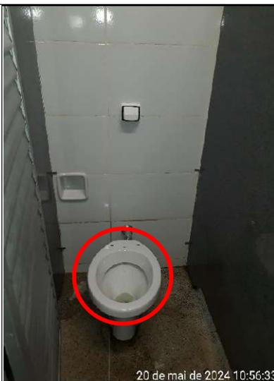
Figura 297 – Detalhe da ausência de assento na bacia sanitária
