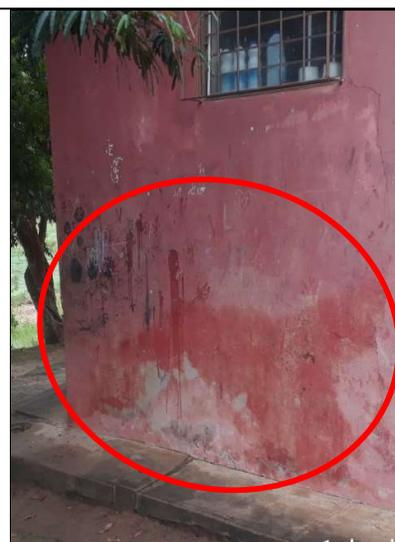
Figura 25 - Detalhe da precariedade da pintura da parede, lado externo
