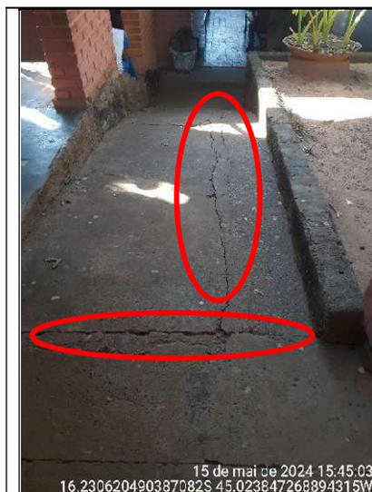
**Figura 230 - Detalhes de rachaduras na calçada**
