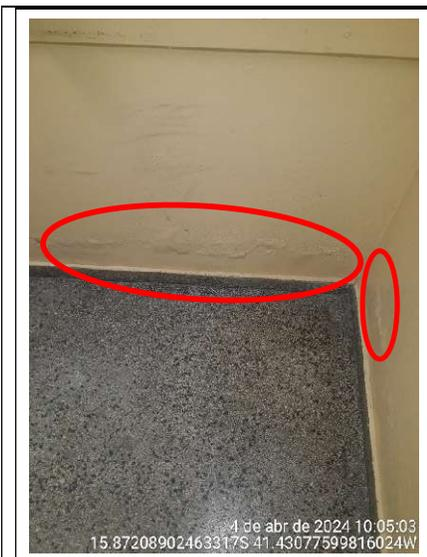
**Figura 71 - Detalhe de umidade na parede da sala de aula**
