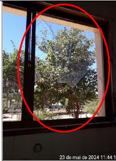
Figura 366 – Detalhe da janela do banheiro com vidro quebrado
