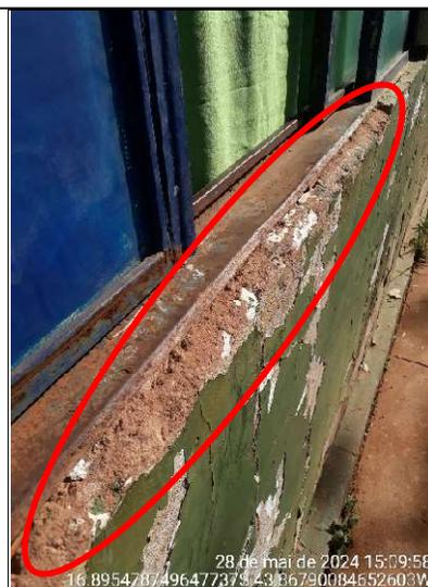
**Figura 151 - Detalhe de desgaste do revestimento da parede, lado externo**
