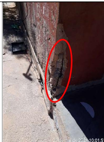
**Figura 385 – Detalhe de pilar sem recobrimento**
