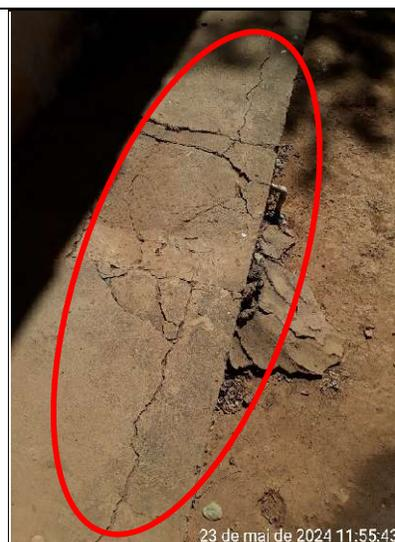
**Figura 349 – Detalhes de rachaduras na calçada**
