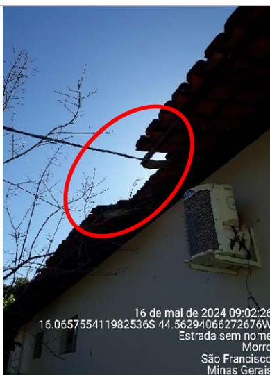
**Figura 189 – Detalhe de problema no beiral devido à quebra do madeiramento**
