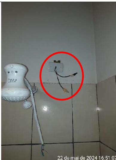
**Figura 318 – Detalhe de cabos elétricos com remendos**
