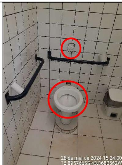
**Figura 164 – Detalhes das ausências: de acabamento de metal para acionamento da válvula de descarga para PcD e de assento na bacia sanitária**
