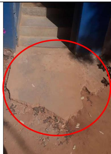
Figura 289 – Detalhe de trecho quebrado da calçada
