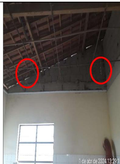
Figura 61 - Detalhes de cabos elétricos pendurados em função da queda parcial do forro de PVC
