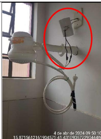
**Figura 75 - Detalhe de cabo elétrico aparente e com remendo**
