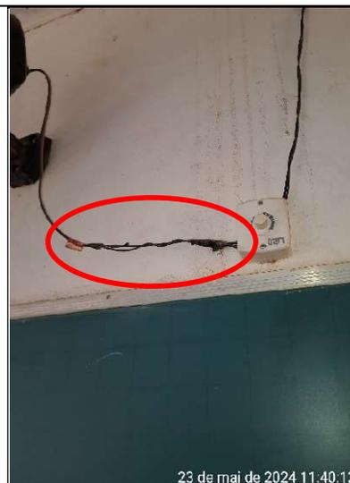
**Figura 373 – Detalhe de cabos elétricos aparentes e com remendos**
