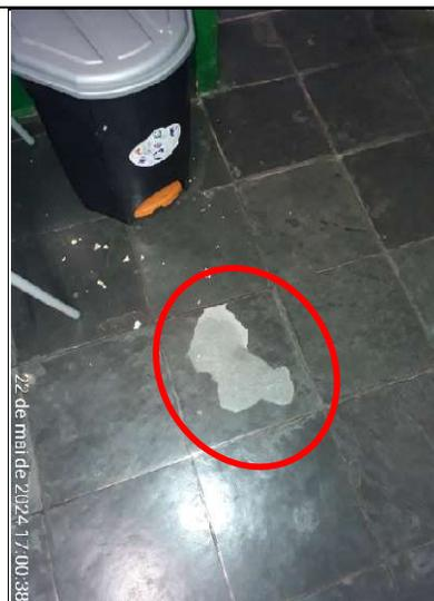
**Figura 310 – Detalhe de desgaste no piso da sala de aula**
