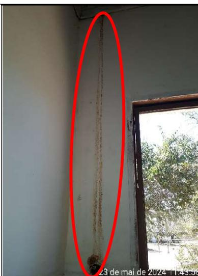
**Figura 363 – Detalhe das manchas de infiltração na parede do banheiro**
