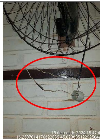
Figura 238 - Detalhes de cabos elétricos aparentes e com remendos na sala de aula...
