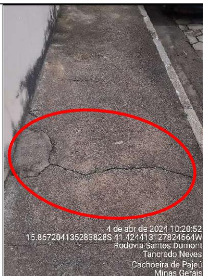
**Figura 68 - Detalhe de rachaduras na calçada, lado externo**
