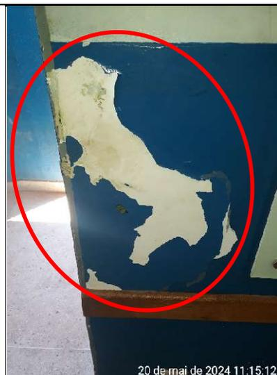
Figura 293 – Detalhe de desgaste da pintura da parede da sala de aula
