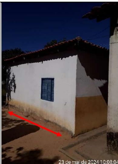
**Figura 384 – Detalhe de telhado sem calçada**
