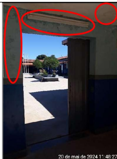
Figura 290 – Detalhe da precariedade da pintura na parede e laje da entrada da escola
