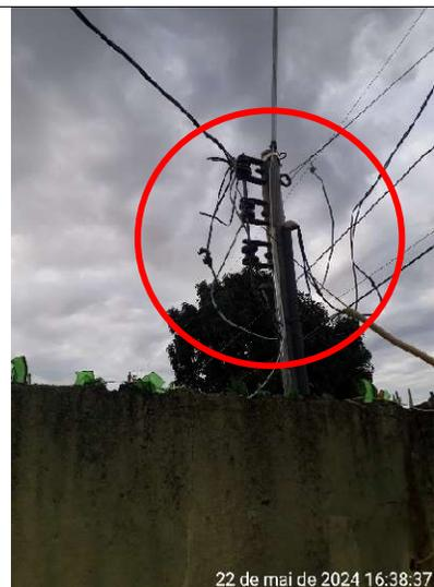
**Figura 317 – Detalhes de remendos de cabos elétricos no poste de entrada de energia**
