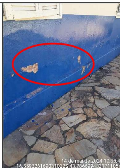
**Figura 118 - Detalhes de desgastes na pintura da parede, lado externo**
