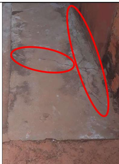
**Figura 262 – Detalhes de rachaduras na calçada**
