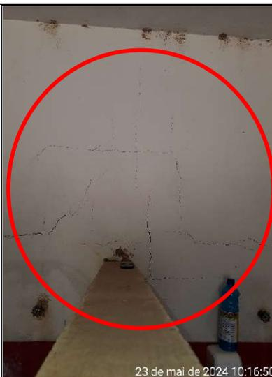
Figura 393 – Detalhes de trincas e rachaduras na parede do banheiro
