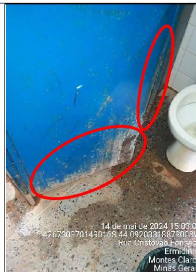
**Figura 91 - Detalhe de ferrugem na porta do box do banheiro**
