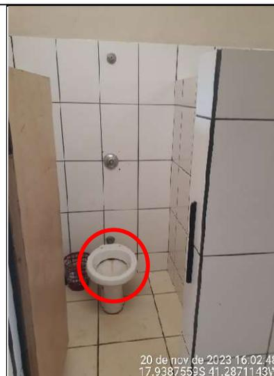
**Figura 10 - Detalhe da ausência de assento na bacia sanitária**
