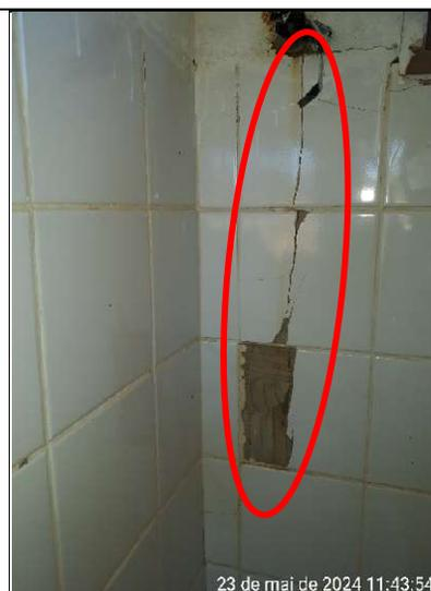
**Figura 361 – Detalhe de rachadura na parede do banheiro**
