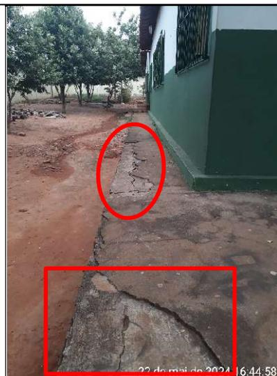
**Figura 308 – Detalhes de trechos quebrados da calçada**
