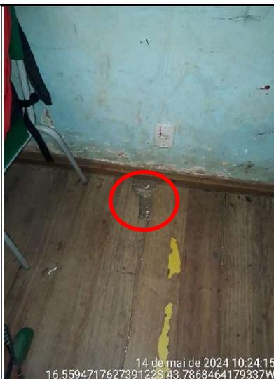
**Figura 111 – Detalhe de buraco no piso da sala de aula**
