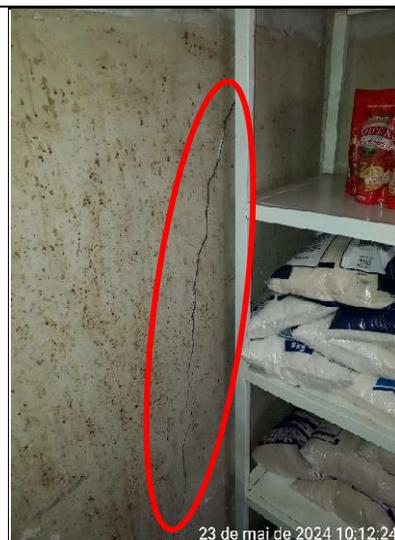
Figura 391 – Detalhe de rachadura na parede da cozinha
