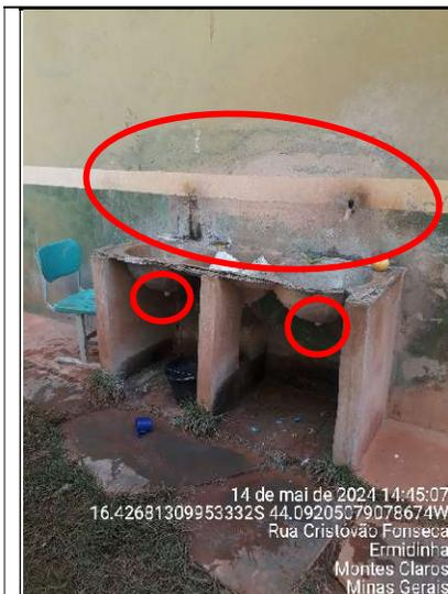
**Figura 98 - Detalhes da precariedade da pintura da parede e das instalações sanitárias do tanque, sem sifões**
