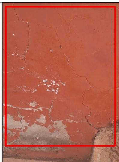
**Figura 266 – Detalhes de trincas e rachaduras na parede, lado externo**
