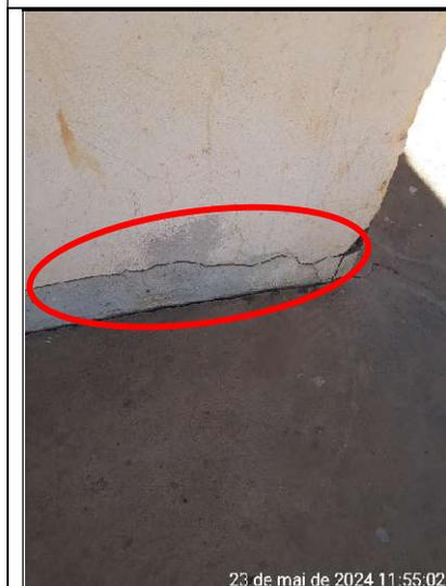
**Figura 356 – Detalhe de rachadura na parede, lado externo**
