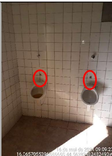
**Figura 192 - Detalhe dos mictórios sem uso, devido a falta dos engates**
