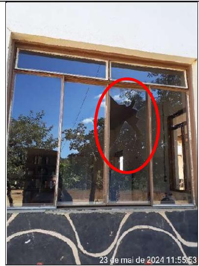
Figura 367 – Detalhe da janela da cozinha com vidro quebrado
