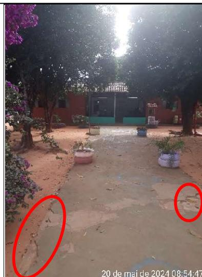
**Figura 259 – Detalhes de trechos quebrados da calçada de acesso à escola**
