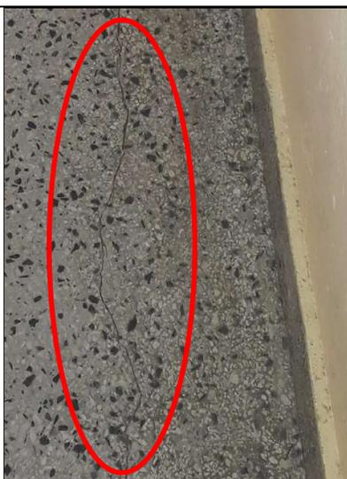
**Figura 69 - Detalhe de trinca no piso da sala de aula**
