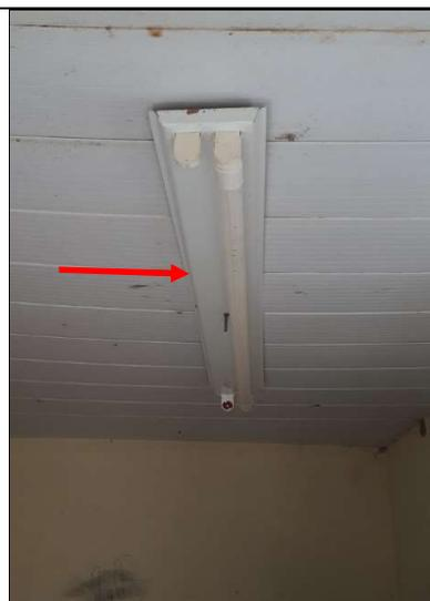
**Figura 343 – Detalhe de ausência de lâmpada na luminária do banheiro**
