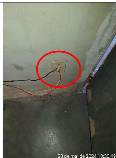
Figura 410 - Detalhe de cabos elétricos conectados diretamente na tomada sem conector (plug)
