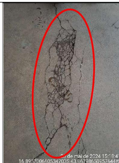
**Figura 139 - Detalhe de trecho quebrado do piso do pátio**
