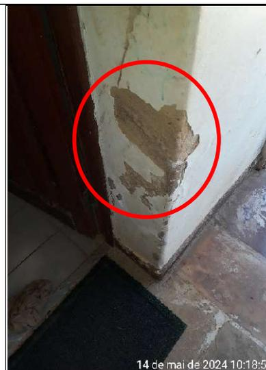
**Figura 115 - Detalhe de problema no revestimento da parede**
