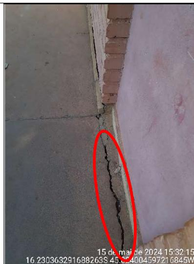
Figura 227 - Detalhe de rachadura na calçada
