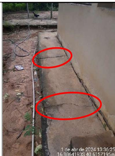
**Figura 44 - Detalhes de rachaduras na calçada**
