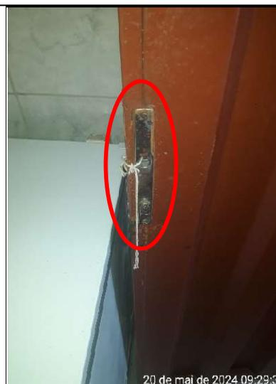
**Figura 274 – Detalhe da ausência de maçaneta na porta da despensa**
