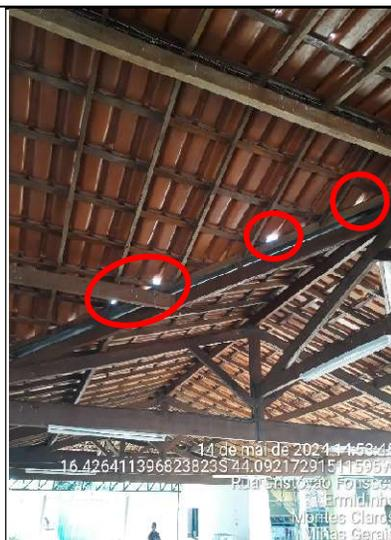
**Figura 99 - Detalhes de pontos de luz na cobertura**
