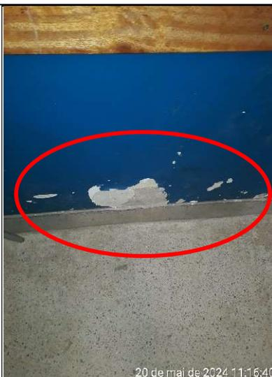
Figura 294 – Detalhe de desgaste da pintura da parede da sala de aula...
