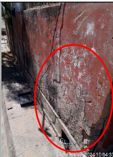
**Figura 387 – Detalhes de trincas e rachaduras na parede frontal**
