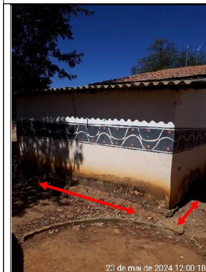
**Figura 350 – Detalhes de trechos sem calçada**
