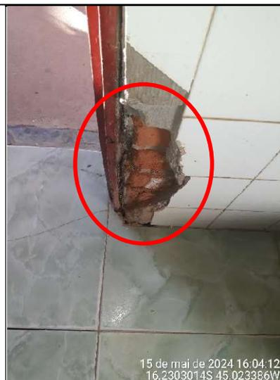
Figura 236 – Detalhe de trecho quebrado da parede do banheiro masculino
