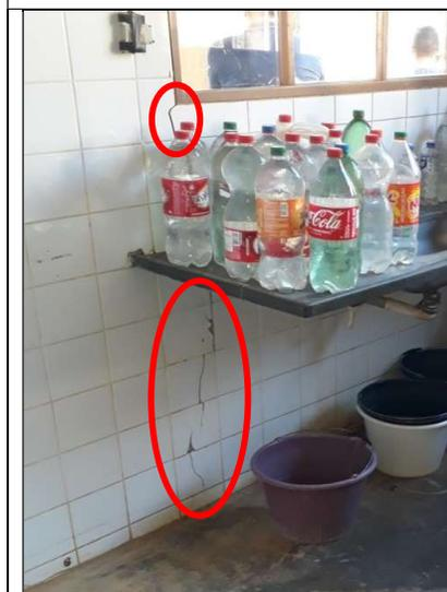
**Figura 362 – Detalhe de rachadura na parede da cozinha**
