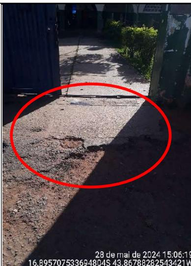
**Figura 135 - Detalhe de irregularidade no concreto da rampa de acesso à escola**
