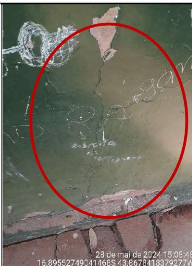
**Figura 147 - Detalhe de trincas na parede, lado externo**
