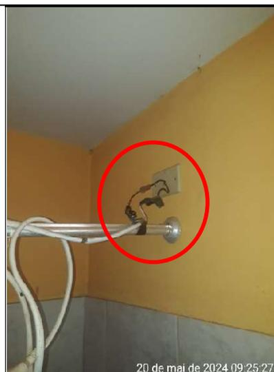
**Figura 272 – Detalhe de cabo elétrico aparente e com remendo**
