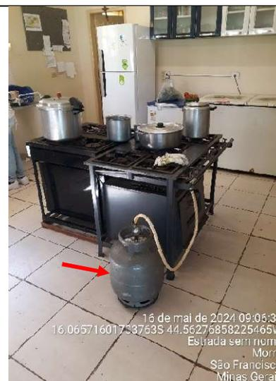
**Figura 202 – Detalhe de botijão de GLP no fogão**
