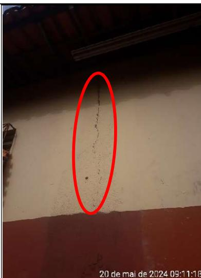
**Figura 267 – Detalhe de rachadura na parede, lado externo**
