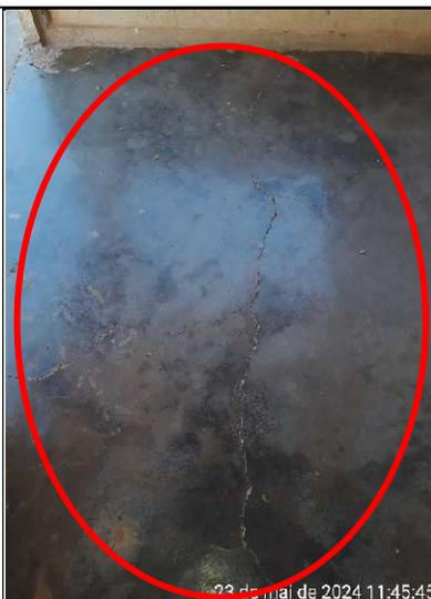
**Figura 354 – Detalhes de rachaduras e manchas no piso do pátio**
