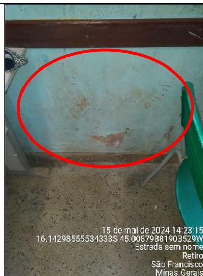
**Figura 215 - Detalhe do desgaste da pintura da parede da sala de aula...**
