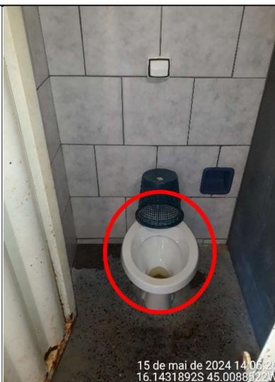
**Figura 222 - Detalhe da ausência de assento na bacia sanitária**
