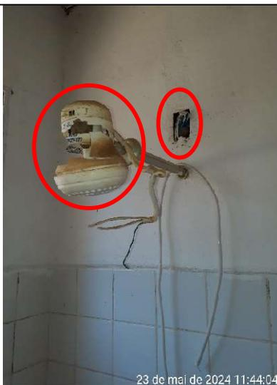
**Figura 372 – Detalhes de cabos elétricos aparentes e chuveiro em situação precária**
