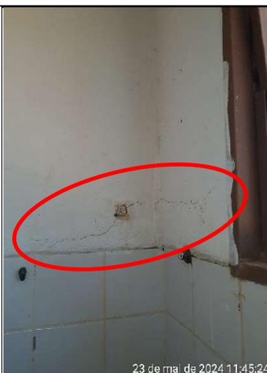
**Figura 360 – Detalhe de rachadura na parede do banheiro**
