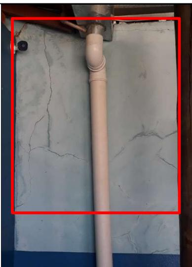
Figura 291 – Detalhes de rachaduras na parede, lado externo
