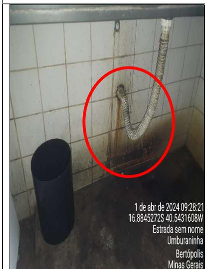
Figura 38 – Detalhe de vazamento de efluente de esgoto, sob a pia da cozinha
