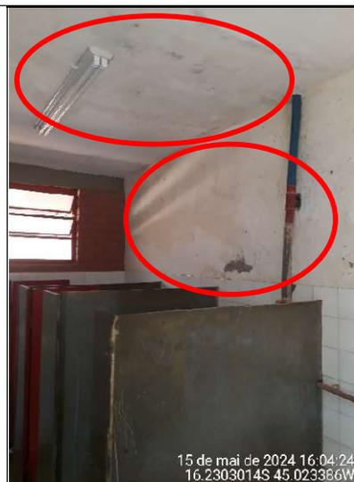
**Figura 245 – Detalhes das manchas de infiltração na laje e parede do banheiro masculino**
