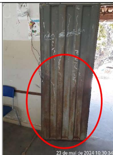
**Figura 404 – Detalhes da porta da sala de aula: com ferrugem e sem fechadura e maçaneta**
