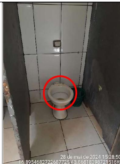
**Figura 166 – Detalhe da ausência de assento na bacia sanitária...**
