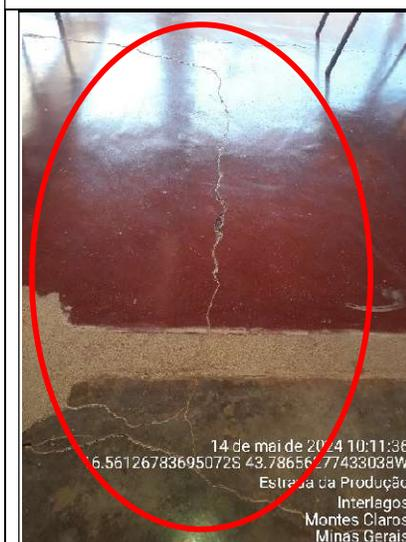
**Figura 107 - Detalhe de rachaduras no piso da varanda externa**
