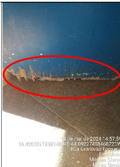
**Figura 90 - Detalhe de desgaste devido à umidade na parte inferior da porta do banheiro masculino**
