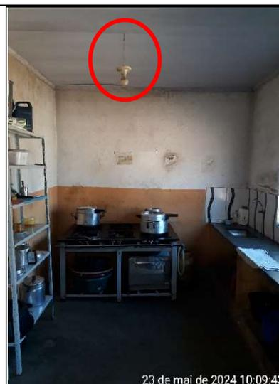
Figura 412 - Detalhe da lâmpada queimada na cozinha
