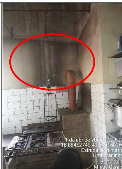
Figura 27 - Detalhe da precariedade da pintura da parede da cozinha
