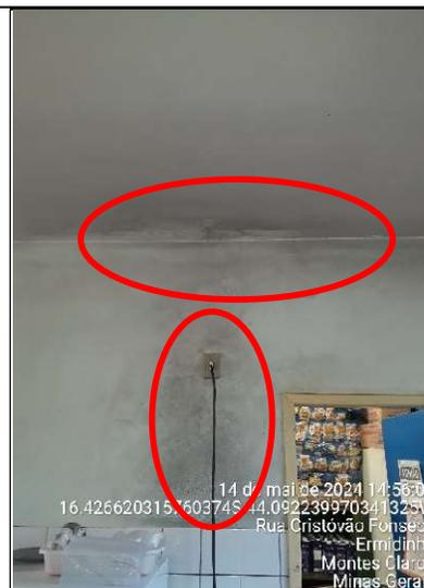
**Figura 88 - Detalhes de manchas de umidade na laje e parede da cozinha**
