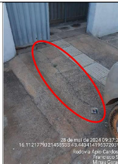
**Figura 421 – Detalhe de rachadura na rampa da entrada principal da escola**
