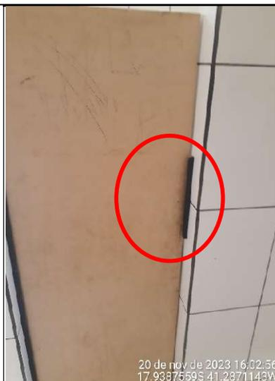
**Figura 9 - Detalhe da ausência de trinco na porta do box do banheiro**
