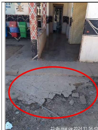
**Figura 347 – Detalhe do acesso principal à escola, com concreto quebrado**
