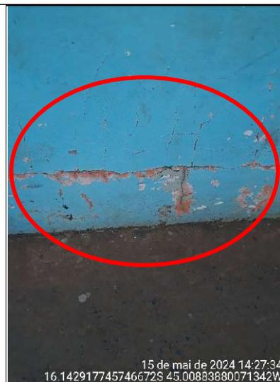
**Figura 208 - Detalhe do desgaste na pintura da parede, lado externo**
