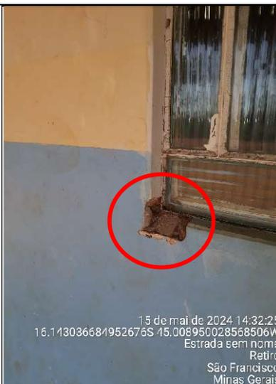
**Figura 216 - Detalhe de trecho quebrado da parede, lado externo**
