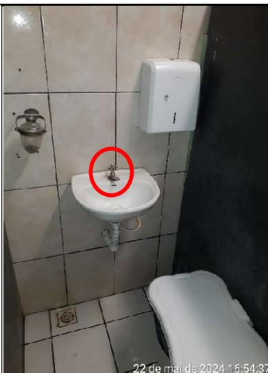
Figura 321 - Detalhe da ausência de metal para acionamento da torneira do lavatório para PcD
