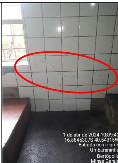
Figura 24 - Detalhe de trinca na parede da cozinha
