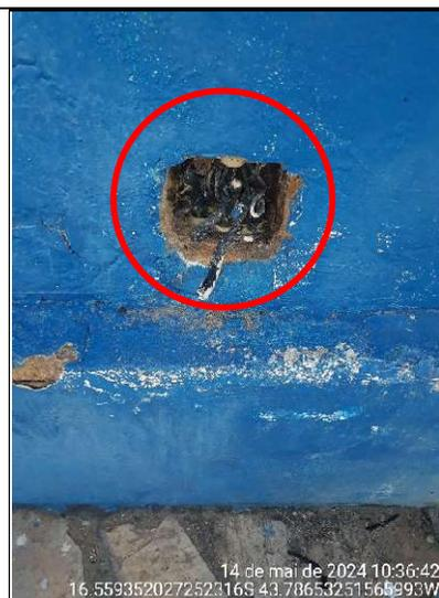
**Figura 127 - Detalhe de cabo elétrico aparente devido à ausência do espelho da tomada**
