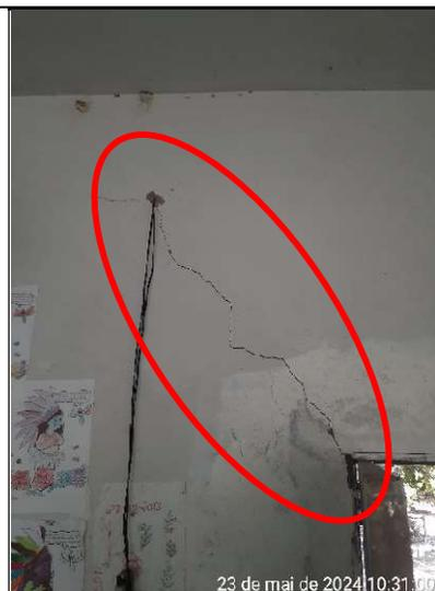
**Figura 395 – Detalhe de rachadura na parede da sala de aula**
