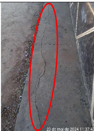
**Figura 348 – Detalhe de rachadura na calçada**
