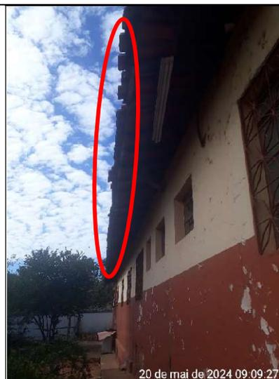
Figura 278 – Detalhe do desalinhamento das telhas do beiral da cobertura
