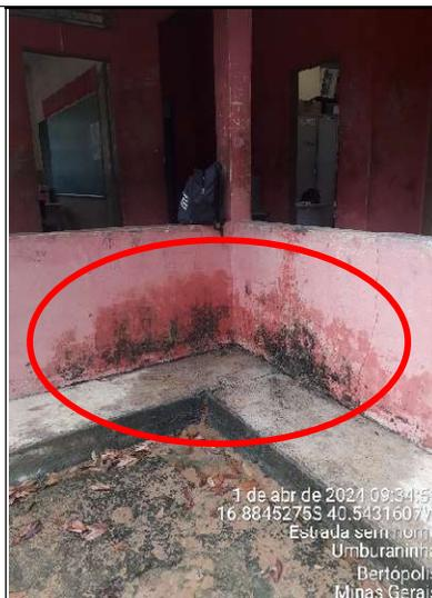
**Figura 21 - Detalhe de manchas de infiltração na parede, lado externo**
