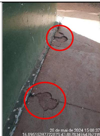
**Figura 137 - Detalhes de trechos quebrados da calçada perimetral**
