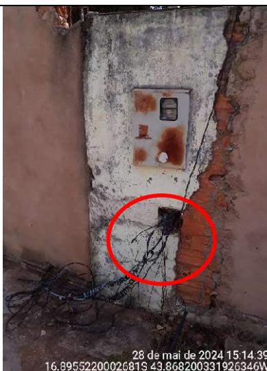
**Figura 168 – Detalhes de cabos elétricos aparentes e com remendos...**
