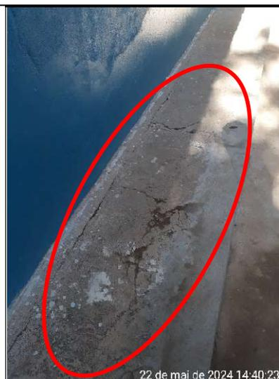
**Figura 329 – Detalhes de trincas e rachaduras na calçada**
