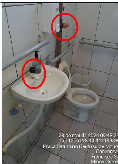
**Figura 441 – Detalhes das ausências dos metais para acionamento da torneira e da válvula de descarga para PcD**
