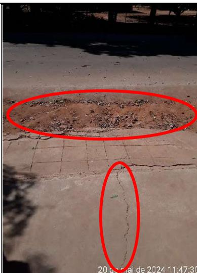
Figura 288 – Detalhes de trecho em terra e rachadura na rampa de acesso à escola
