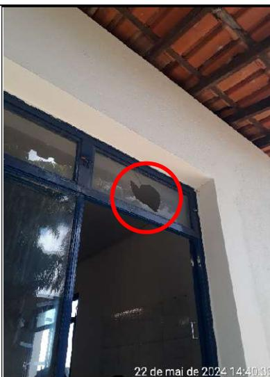
**Figura 336 – Detalhe da janela da sala de aula com vidro quebrado**
