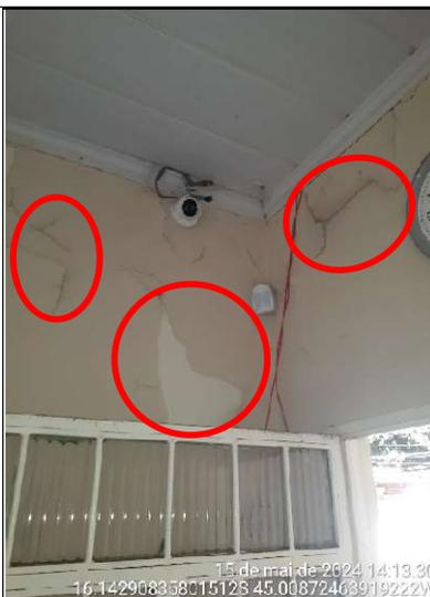
Figura 213 - Detalhes do desgaste da pintura da parede da cozinha
