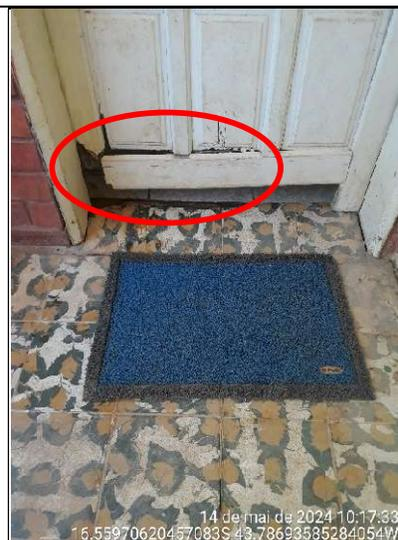
**Figura 124 – Detalhe do mau estado de conservação da porta do banheiro masculino devido à umidade**
