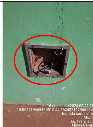
**Figura 196 - Detalhe de cabos elétricos aparentes e com remendos**
