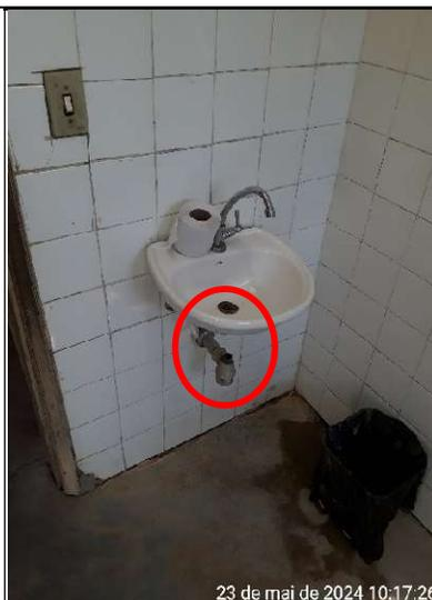
Figura 414 – Detalhe da ausência do copo do sifão do lavatório
