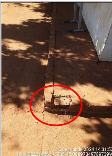
**Figura 204 - Detalhe de trecho quebrado da calçada, lado interno**
