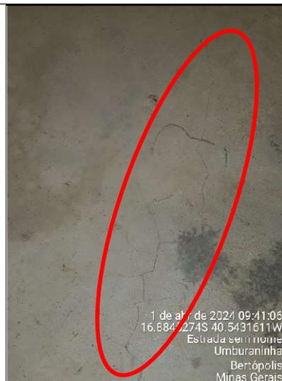
**Figura 20 – Detalhe de trinca no piso da sala de aula**
