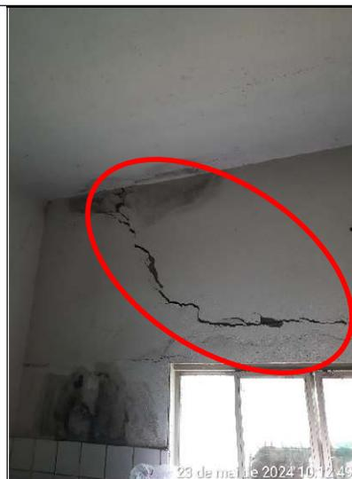
Figura 392 – Detalhe de rachadura na parede da cozinha
