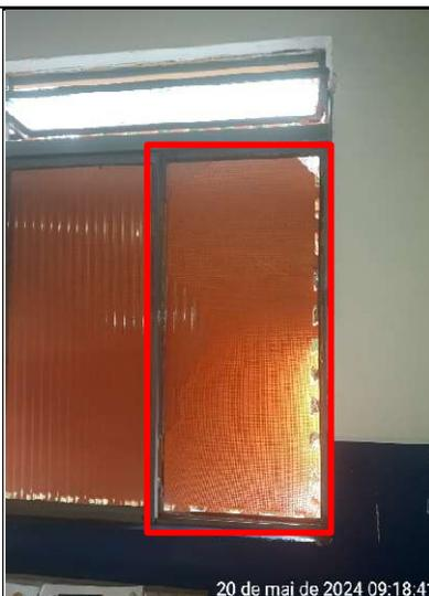
Figura 276 – Detalhe da janela da sala de aula com vidro quebrado
