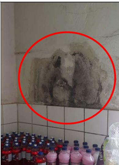
**Figura 399 – Detalhe de mancha de infiltração na parede da cozinha**
