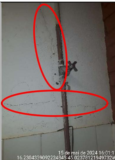
**Figura 234 - Detalhes de trincas na parede do banheiro feminino**
