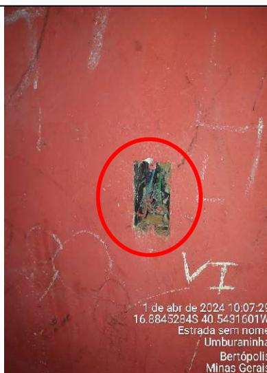
Figura 36 - Detalhe de tomada sem espelho e com cabos elétricos aparentes e com remendos
