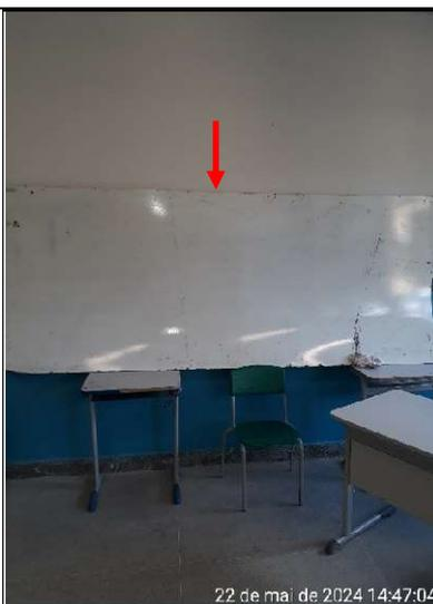
**Figura 342 – Detalhe do quadro (lousa) da sala de aula solto da parede**
