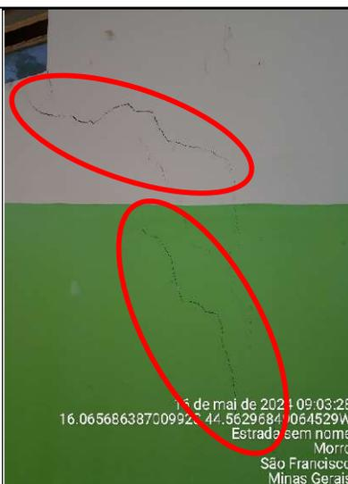
**Figura 186 - Detalhes de rachaduras na parede, lado externo**
