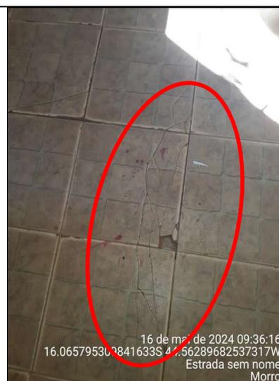
Figura 184 - Detalhe de piso quebrado na sala de aula
