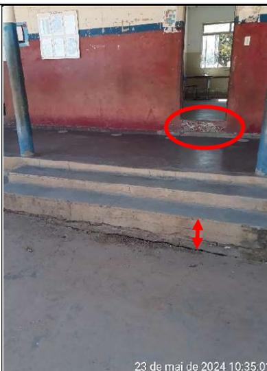
**Figura 378 – Detalhes da escada de acesso à escola, com altura do espelho em desacordo com a Norma. Ao fundo o desnível para acesso à sala de aula**
