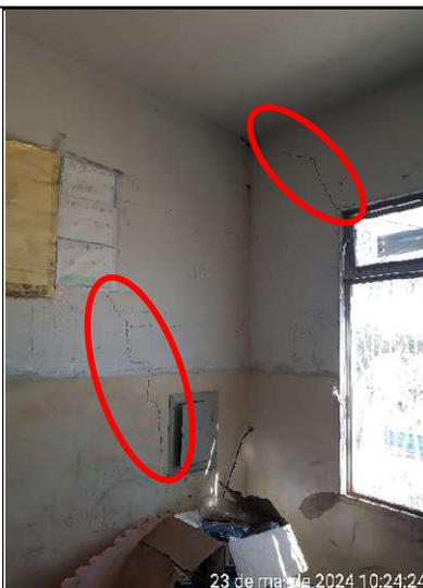
**Figura 396 – Detalhes de rachaduras na parede da sala de aula**
