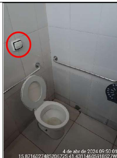
**Figura 76 - Detalhe da ausência de metal para acionamento da válvula de descarga para PcD**
