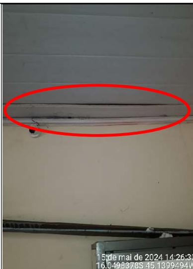
**Figura 219 - Detalhe do deslocamento do forro da sala de aula devido à infiltração**
