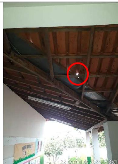
**Figura 316 – Detalhe de fresta de luz na cobertura**
