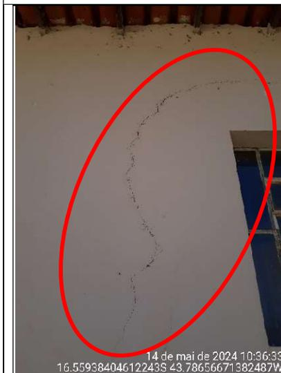
**Figura 119 - Detalhe da rachadura na parede, lado externo**
