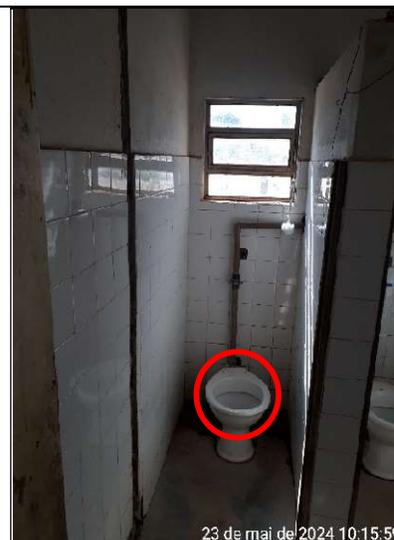
Figura 415 – Detalhe da ausência de assento na bacia sanitária
