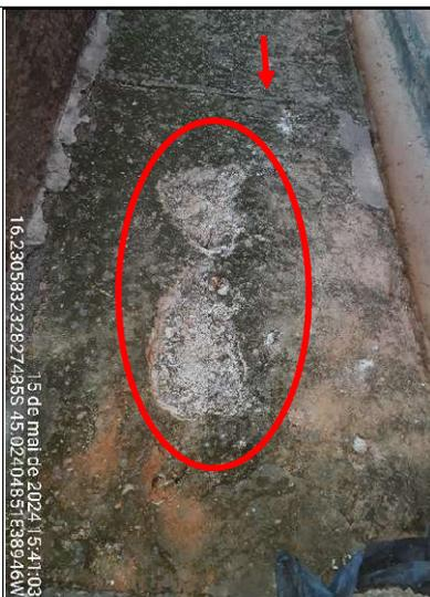
Figura 228 - Detalhes de buracos e rachadura na calçada
