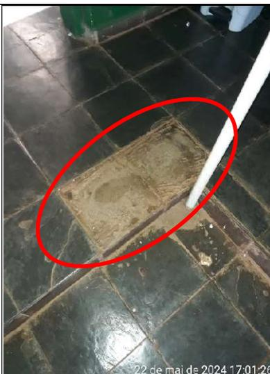
**Figura 312 – Detalhe de descolamento de pisos no pátio**
