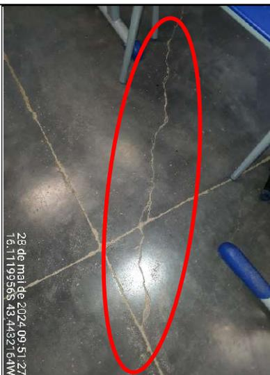
**Figura 426 – Detalhe de rachadura no piso da sala de aula**
