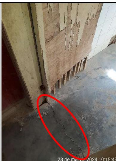
**Figura 381 – Detalhe de rachadura no piso do banheiro**
