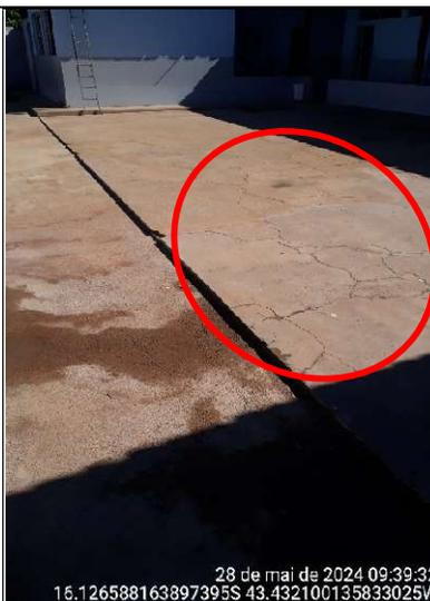
**Figura 423 – Detalhe de rachaduras no piso do pátio descoberto interno**
