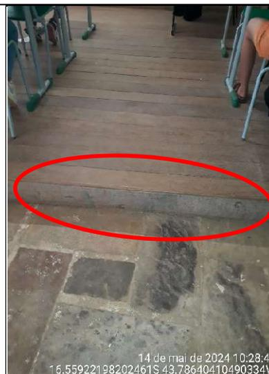
**Figura 112 – Detalhe de desnível entre pisos, dentro da sala de aula**
