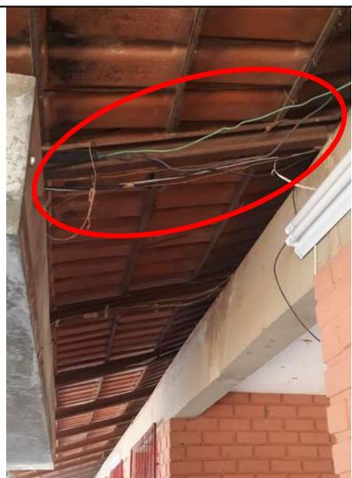
Figura 239 - Detalhes de cabos elétricos aparentes e com remendos
