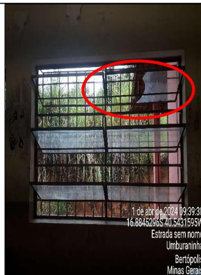
**Figura 31 - Detalhe da janela da sala de aula com vidro danificado**
