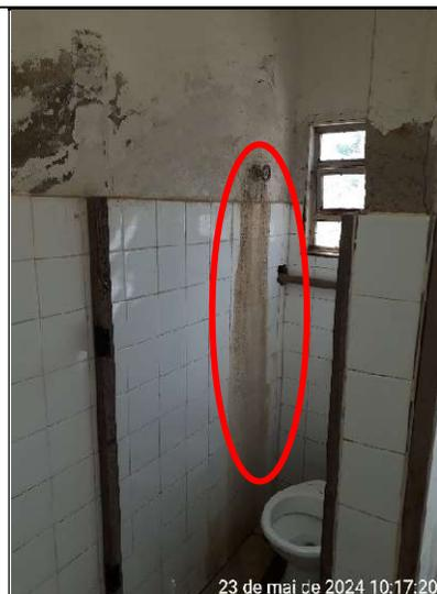
Figura 413 – Detalhe de vazamento no registro
