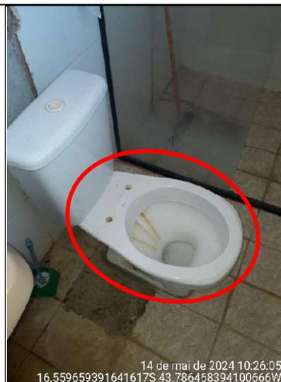
Figura 130 - Detalhe da ausência de assento na bacia sanitária
