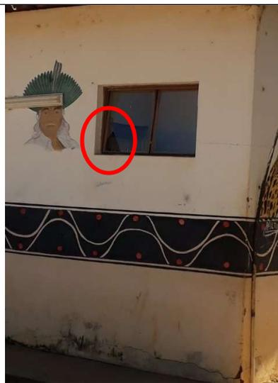
Figura 368 – Detalhe da janela do banheiro com vidro quebrado
