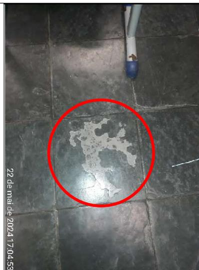
**Figura 311 – Detalhe de desgaste do piso da sala de aula...**
