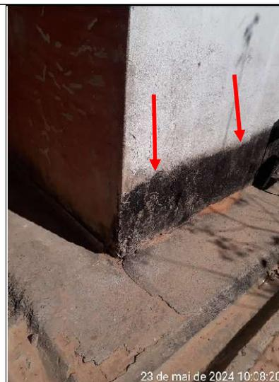
**Figura 400 – Detalhe de mancha de infiltração na parede, lado externo**
