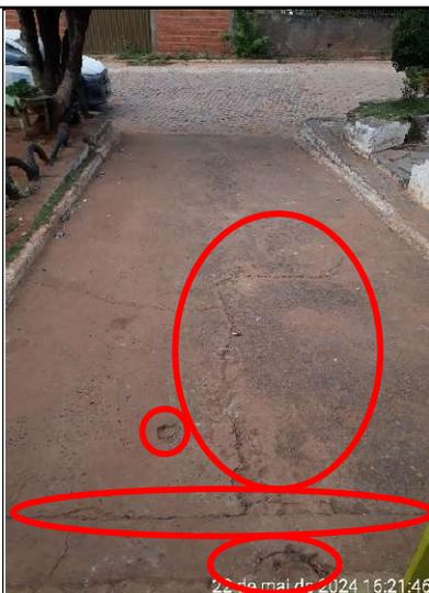
**Figura 303 – Detalhes de buracos e rachaduras na rampa de acesso à escola, lado externo**
