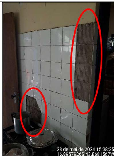
**Figura 146 - Detalhe de trechos sem azulejos na cozinha**
