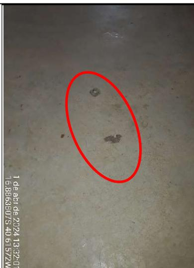
**Figura 45 - Detalhe de furos no piso da sala de aula**
