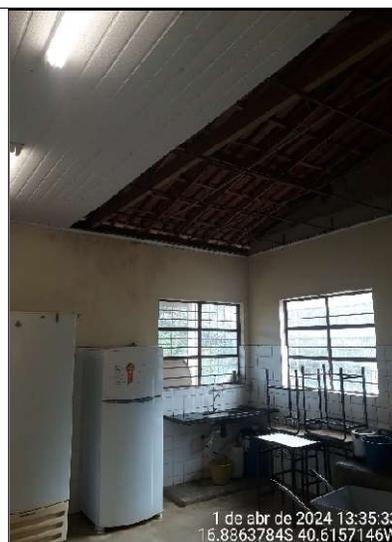
**Figura 52 - Detalhe de trecho sem forro na cozinha**
