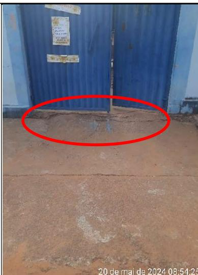
**Figura 258 – Detalhe da falta de acabamento do concreto próximo ao portão de entrada**
