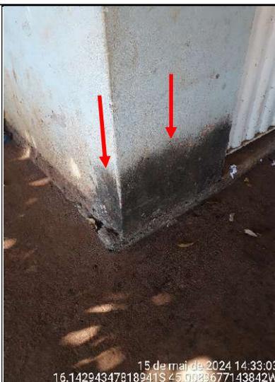
Figura 210 - Detalhe de manchas de infiltração na parede, lado externo...
