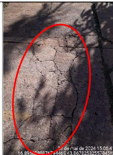
**Figura 136 - Detalhe de trecho quebrado da calçada interna de acesso à escola, logo após a rampa**
