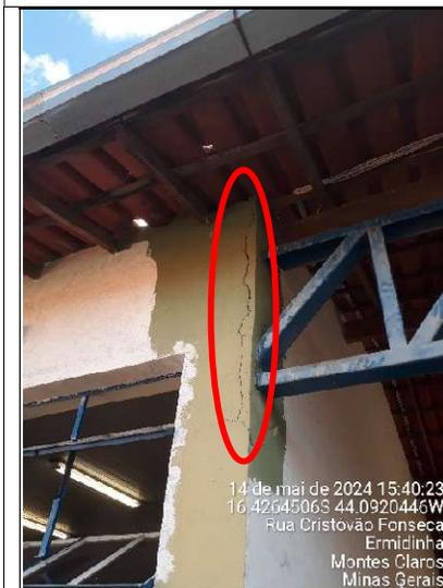
**Figura 89 - Detalhe de rachadura na parede**
