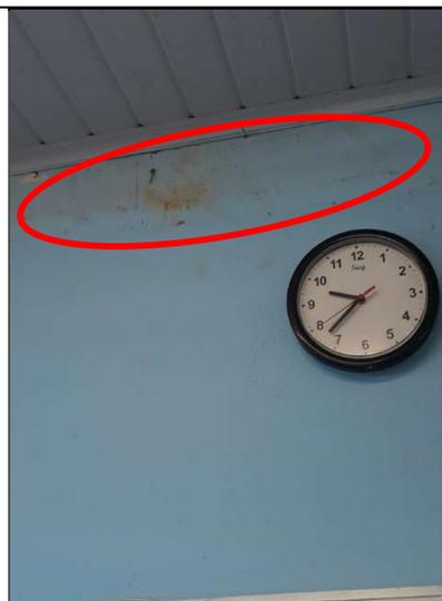
**Figura 437 – Detalhe de manchas de infiltração na parede da sala de aula**
