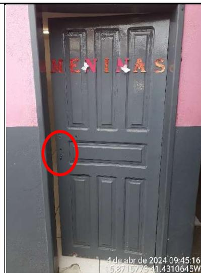
**Figura 73 - Detalhe da ausência de maçaneta na porta do banheiro feminino**
