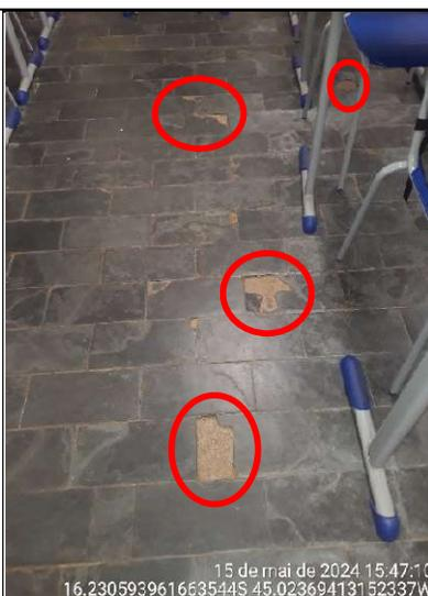
**Figura 231 - Detalhes de pisos quebrados na sala de aula**
