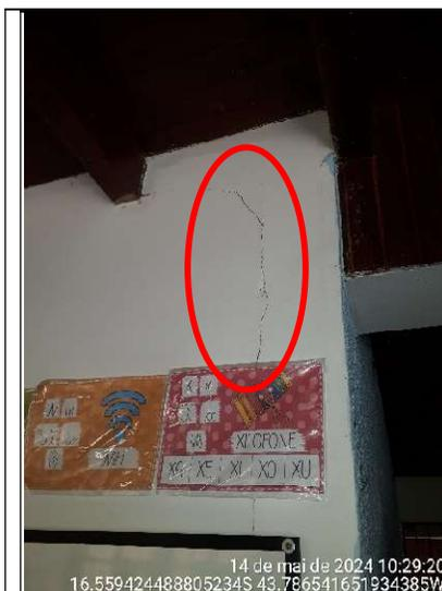
**Figura 116 - Detalhe de rachadura na parede da sala de aula**
