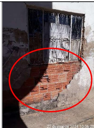
Figura 389 – Detalhe de trecho da parede sem revestimento
