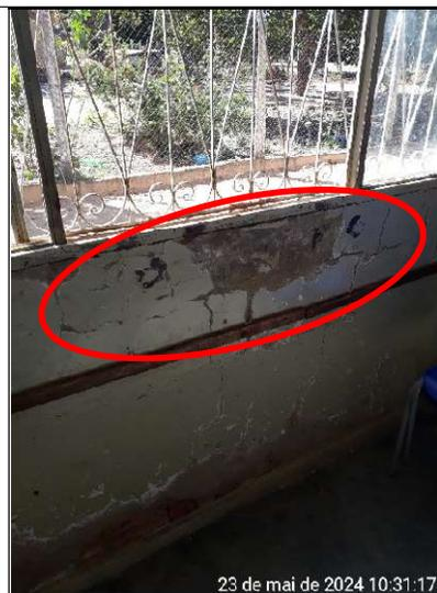
**Figura 398 – Detalhe de trincas na parede da sala de aula**
