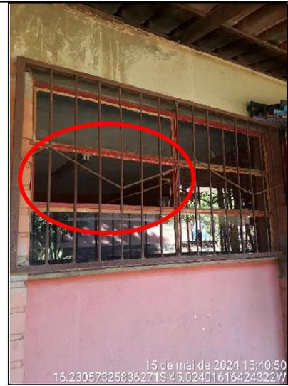
**Figura 250 – Detalhe de vão da janela sem vidro**
