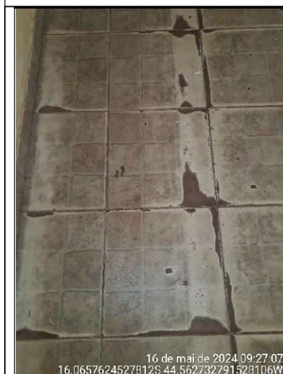
Figura 182 - Detalhe de desgaste do piso da sala de aula
