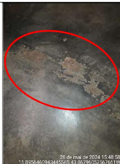
**Figura 143 - Detalhe de desgaste no piso da sala de aula**
