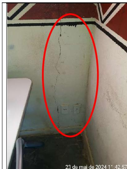
**Figura 359 – Detalhe de rachadura na parede da sala de aula**
