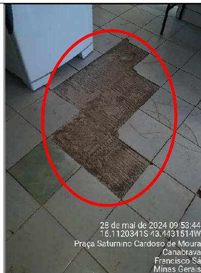
**Figura 428 – Detalhe de descolamento de pisos na cozinha**
