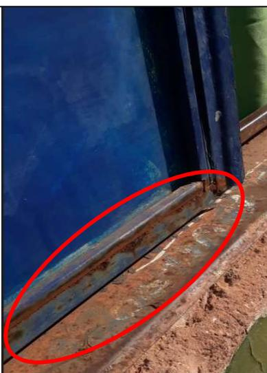
**Figura 156 – Detalhe de ferrugem na janela da sala de aula**
