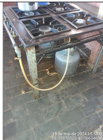
**Figura 256 – Detalhes dos botijões de GLP no fogão**
