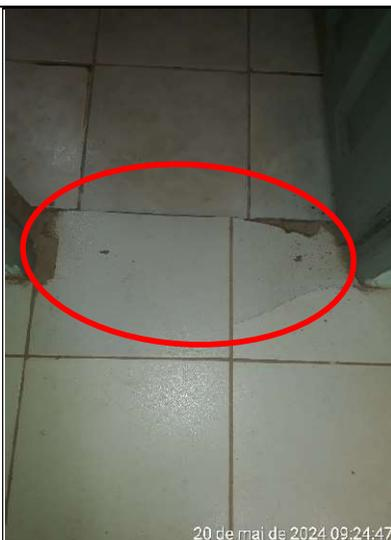
**Figura 264 – Detalhe de piso quebrado na entrada do banheiro feminino**
