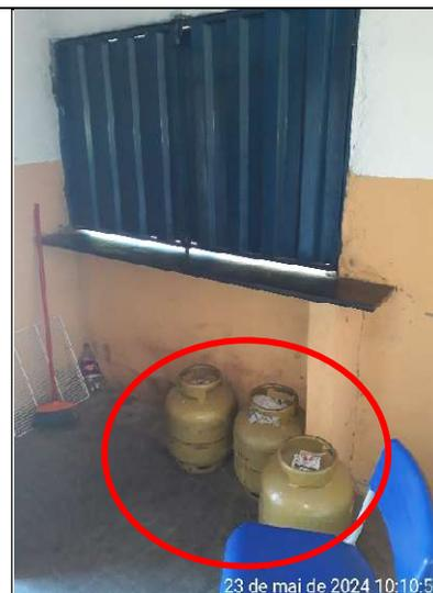
Figura 418 – Detalhe do armazenamento de três botijões de GLP na cozinha
