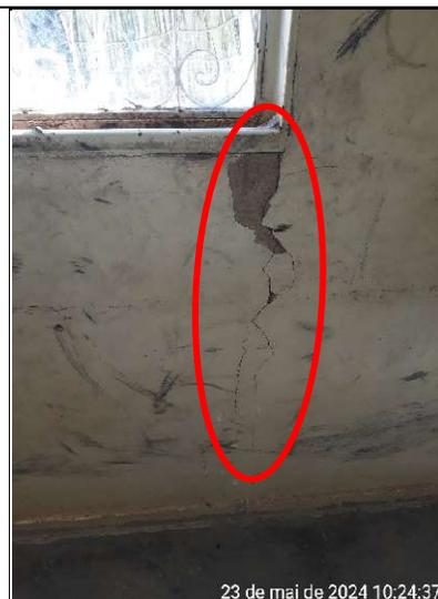
**Figura 397 – Detalhe de rachadura na parede da sala de aula**
