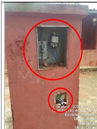
Figura 35 – Detalhes do quadro de entrada de energia sem tampa, com cabos elétricos aparentes e com remendos
