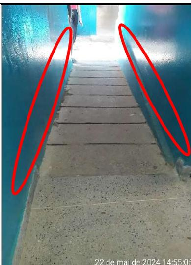
**Figura 330 – Detalhe de rampa sem corrimão**
