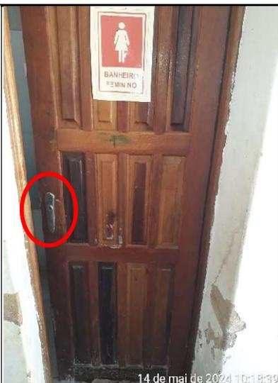
**Figura 123 – Detalhe de ausência de maçaneta na porta do banheiro feminino**
