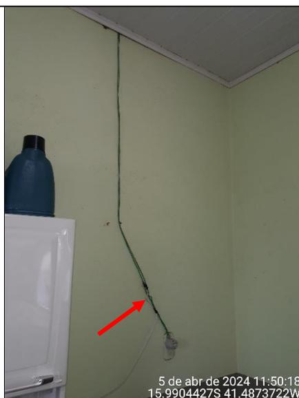
**Figura 79 - Detalhe de cabo elétrico aparente e com remendos**
