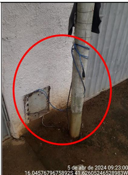
Figura 66 - Detalhe cabo elétrico aparente
