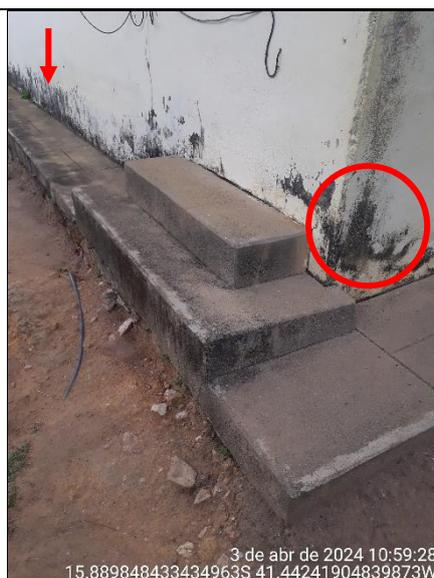
**Figura 28 - Detalhe de desníveis na calçada perimetral e manchas de umidade na parede**
