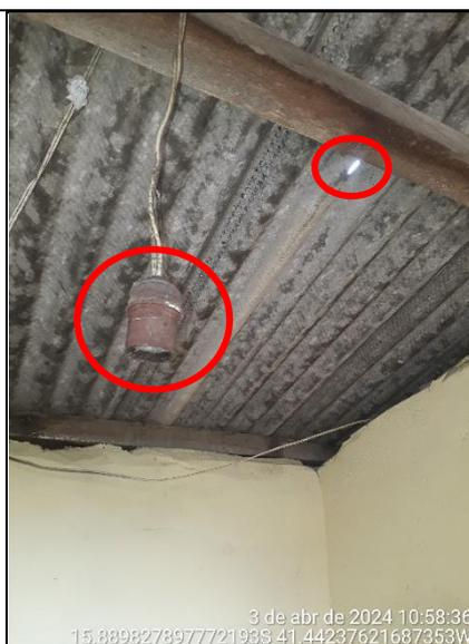
**Figura 40 - Detalhe de falta de lâmpada no banheiro e fresta de luz na cobertura**
