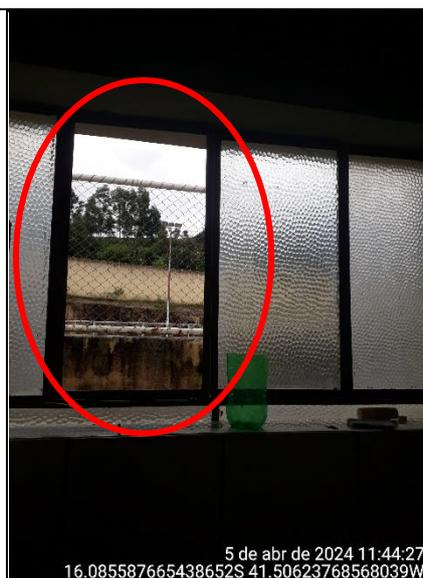
**Figura 76 - Detalhe de vão de janela sem vidro**
