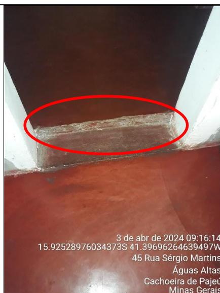
**Figura 4 - Detalhe do desnível na entrada na sala de aula**
