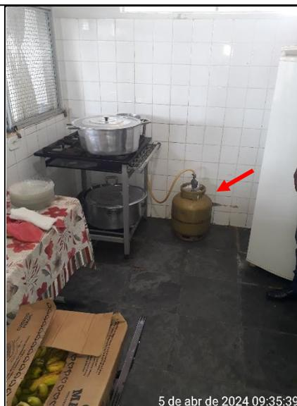
Figura 67 - Detalhe do botijão de gás na cozinha (ausência de central de gás)
