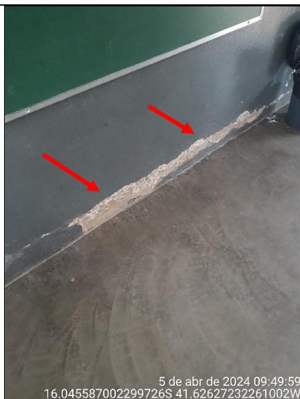
**Figura 61 - Detalhe de problemas no revestimento e pintura**
