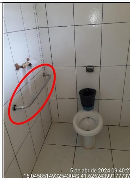
Figura 68 - Detalhes do box para PCD com apenas uma barra de apoio e bacia sanitária sem assento
