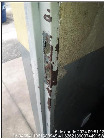
**Figura 64 - Detalhe de precariedade do batente da porta da sala de aula**
