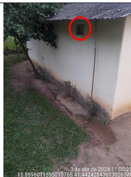
**Figura 41 - Detalhe de vão sem janela no banheiro**
