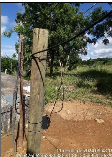
**Figura 19 -** Detalhe de cabo elétrico aparente e com remendos
