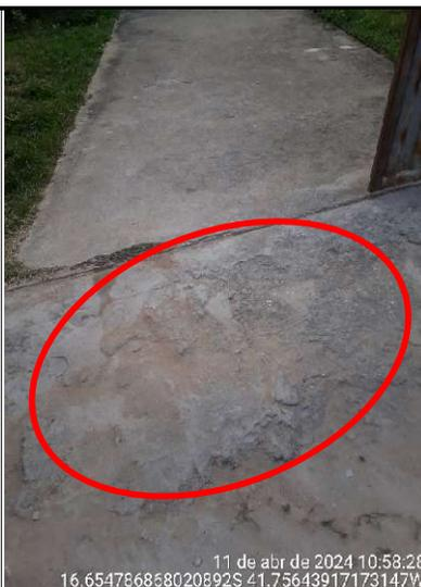
**Figura 28 - Detalhe do concreto sem acabamento da rampa de acesso à escola**
