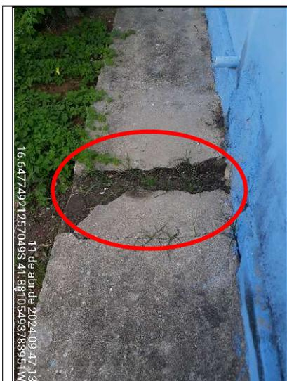
**Figura 3 - Detalhe da calçada com trecho quebrado**
