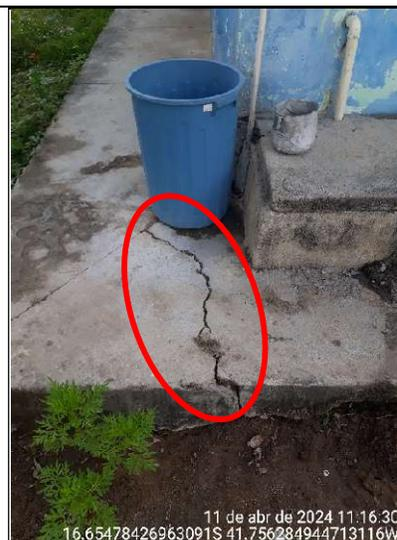
**Figura 29 - Detalhe da rachadura na calçada**
