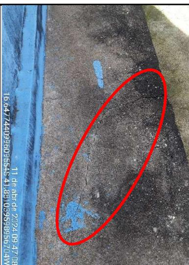
**Figura 4 - Detalhe de trinca na calçada**
