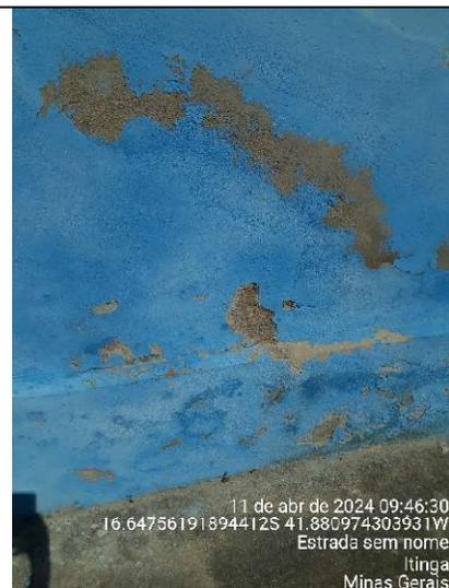
Figura 9 - Detalhe de desgaste na pintura, lado externo
