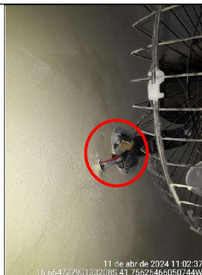
**Figura 38 - Detalhe de remendo de cabo elétrico**
