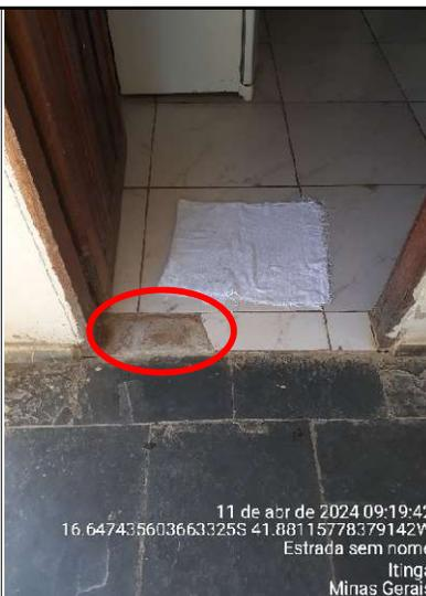
**Figura 7 - Detalhe de piso quebrado na entrada da cozinha**
