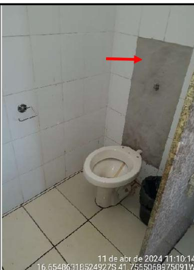
**Figura 31 - Detalhes de bacia sanitária sem assento e parede sem azulejos**
