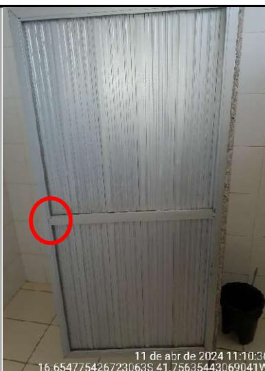
**Figura 37 - Detalhe de porta de box sem trinco/fecho**
