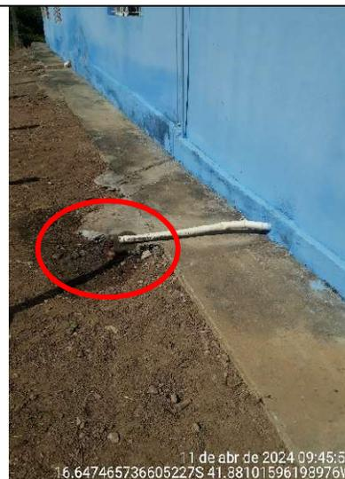
**Figura 17 -** Detalhe de lançamento direto no solo de efluente de esgoto da cozinha
