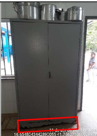
**Figura 34 - Detalhe de ferrugem em armário de aço. Gestor do município comprovou que o referido mobiliário foi substituído por um novo.**
