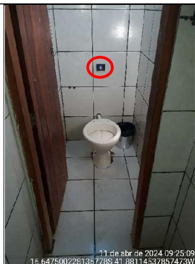
**Figura 18 -** Detalhe de bacia sanitária sem assento e válvula de descarga sem acabamento
