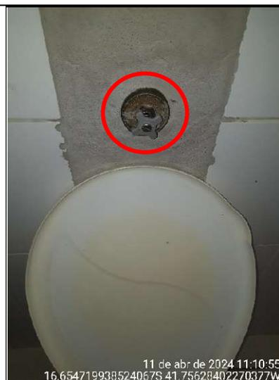
**Figura 32 - Detalhe da válvula de descarga sem acabamento**
