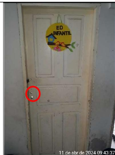
Figura 12 - Detalhe de porta da sala de aula sem maçaneta
