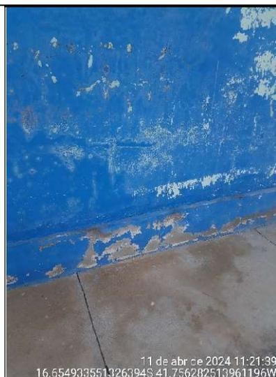
**Figura 30 - Detalhes de desgastes na pintura, lado externo**
