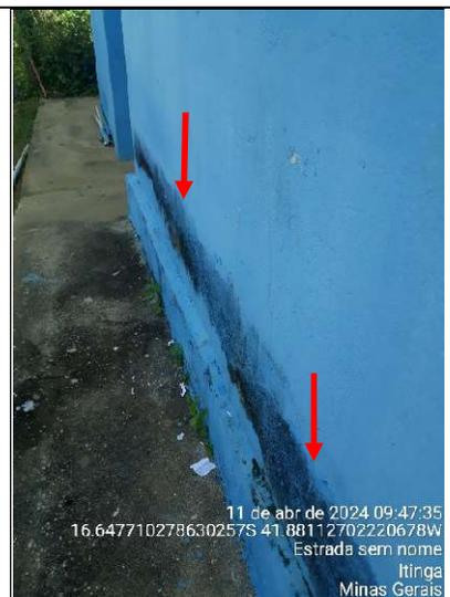
**Figura 8 - Detalhe de manchas de umidade na parede, lado externo**
