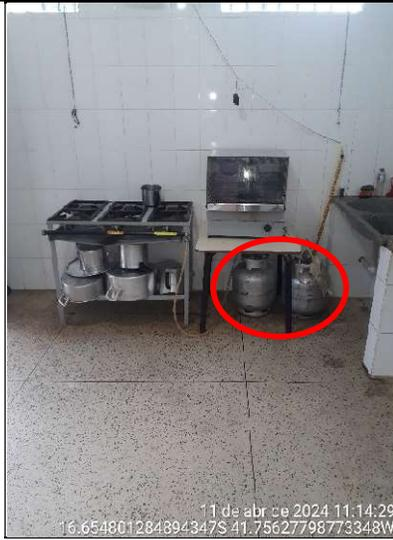
**Figura 39 - Detalhe de dois botijões de GLP em uso (fogão e forno) na cozinha**
