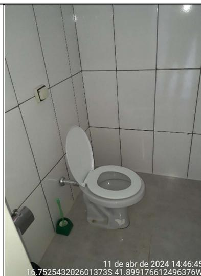
**Figura 25 - Detalhe da ausência de barras e metais específicos para PcD**
