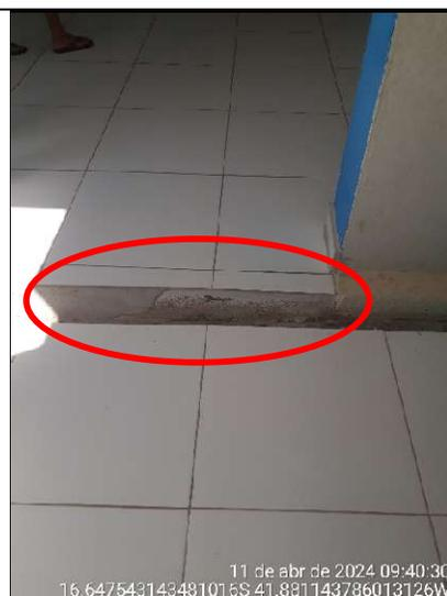
**Figura 5 - Detalhe de desnível na entrada da sala de aula**
