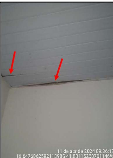
**Figura 16 -** Detalhe de infiltração no forro de PVC
