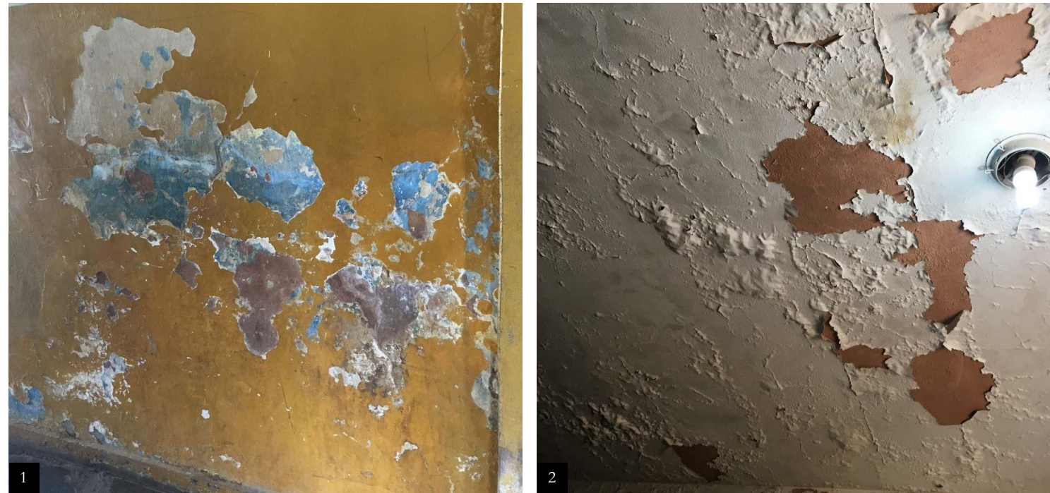
Figura 2: Infiltração no teto.
