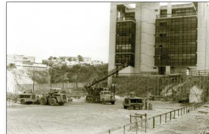
Obras da construção do prédio anexo (foto de julho de 1993)
