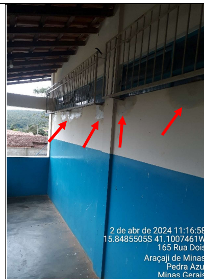
Figura 20 - Detalhe dos locais que necessitam de pintura
