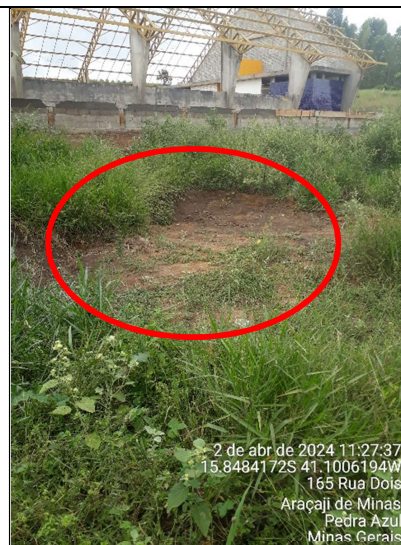
Figura 18 - Detalhe do local da fossa
