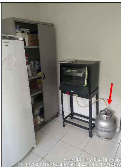
Figura 82 - Detalhe de botijão de gás no forno
