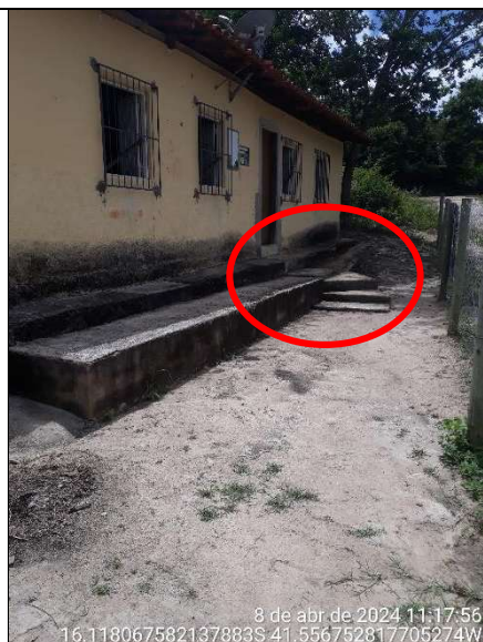
Figura 18 - Detalhe do acesso frontal à escola
