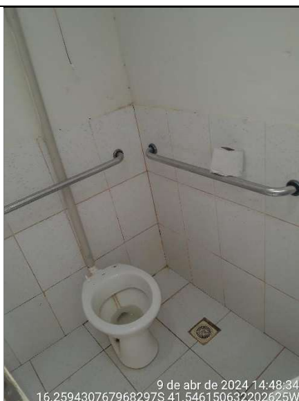
Figura 13 - Detalhe da bacia sanitária sem assento
