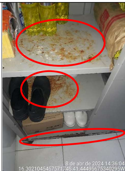
Figura 81 - Detalhe de armário de aço com ferrugem
