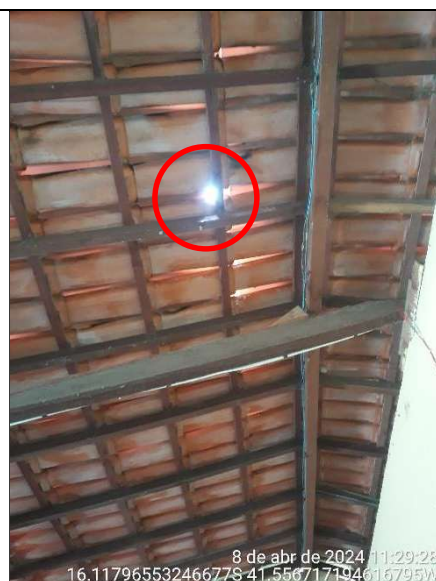
Figura 26 - Detalhe de fresta de luz na cobertura
