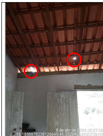
Figura 66 - Detalhe frestas de luz na cobertura
