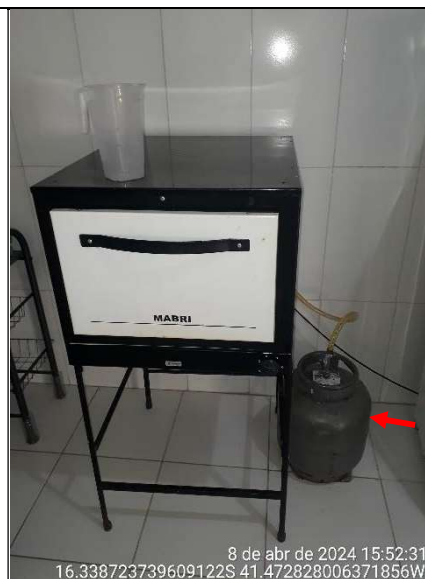
Figura 108 - Detalhe do botijão de GLP no forno
