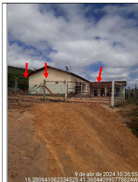
Figura 48 - Detalhe do fechamento do terreno com tela do tipo galinheiro
