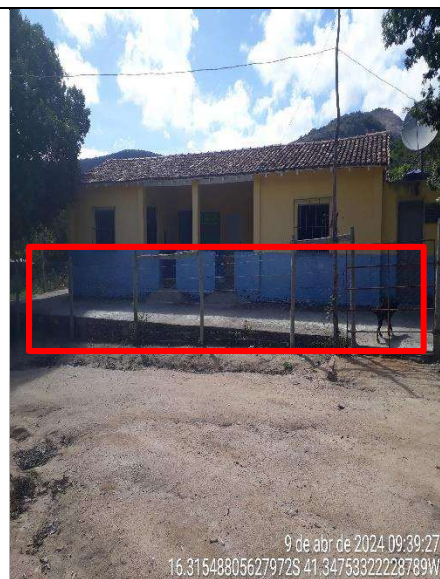
Figura 89 - Detalhe de tela do tipo galinheiro no fechamento do terreno
