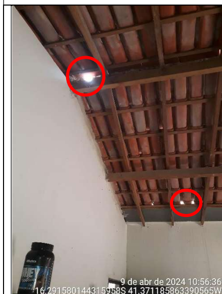
Figura 51 - Detalhe de frestas de luz na cobertura
