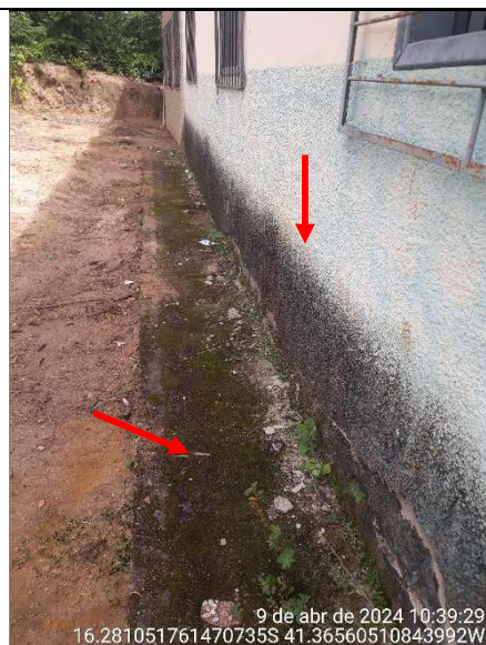
Figura 39 - Detalhes de manchas de umidade na parede e lodo na calçada
