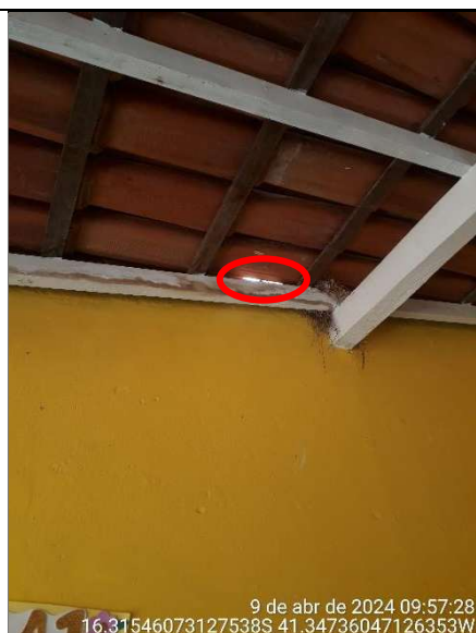
Figura 96 - Detalhe de fresta de luz na cobertura
