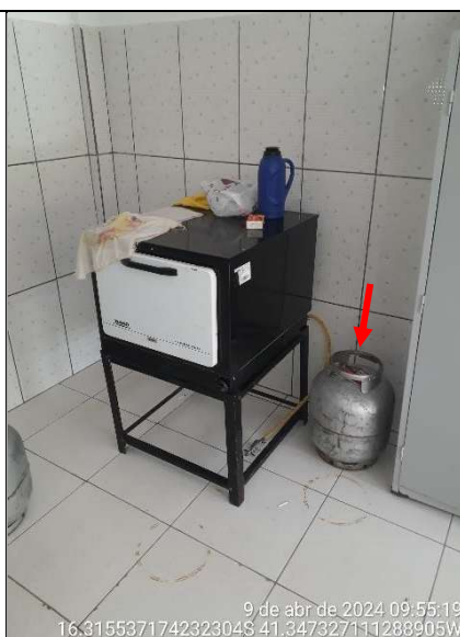
Figura 100 - Detalhe de botijão de GLP no forno
