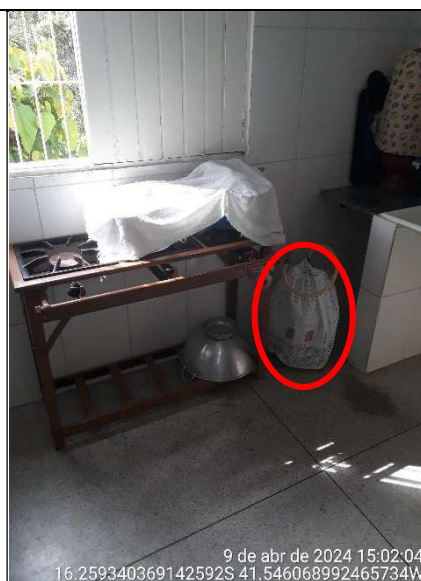
Figura 16 - Detalhe de botijão de GLP na cozinha
