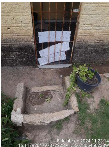
Figura 19 - Detalhe do acesso posterior à escola
