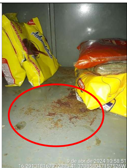
Figura 49 - Detalhe de ferrugem no armário de alimentos
