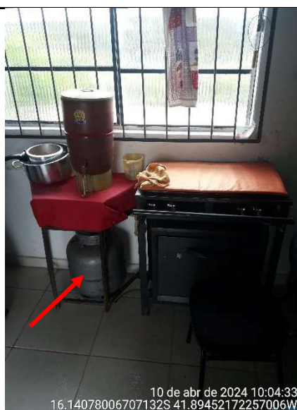
Figura 19 - Detalhe de botijão de GLP no forno
