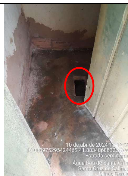
Figura 29 - Detalhe da abertura no piso do banheiro, em substituição à bacia sanitária
