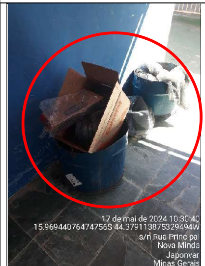
Figura 26 - Detalhe da ausência de coleta seletiva de resíduos
