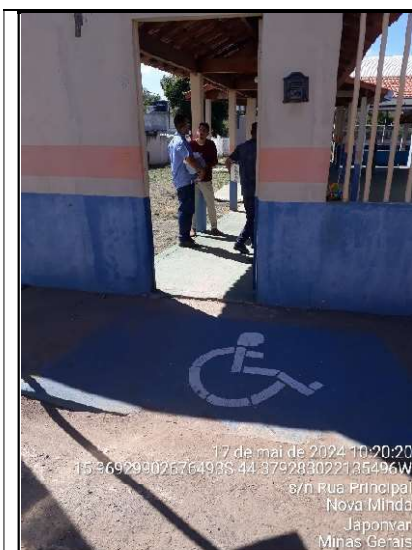
Figura 3 – Detalhe do acesso principal à unidade
