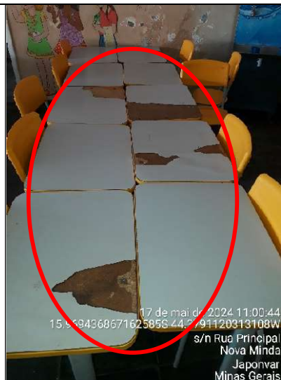
Figura 24 - Detalhe do mau estado de conservação do mobiliário
