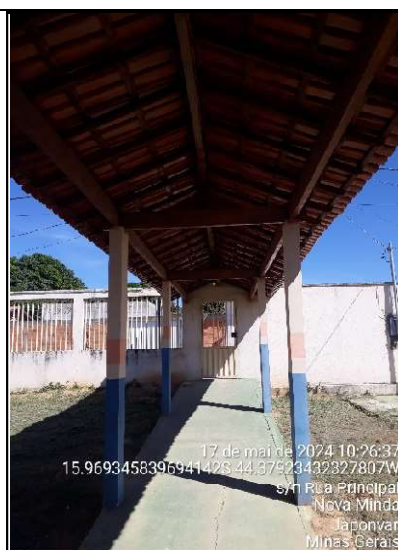
Figura 4 - Detalhe passarela coberta da rampa de acesso à unidade
