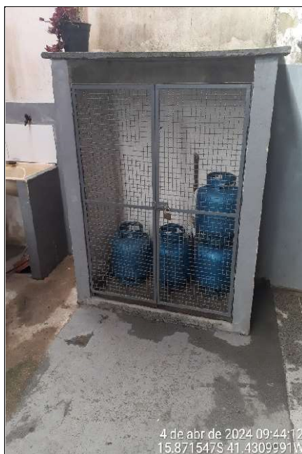
Figura 456 – Detalhe do local para armazenamento de botijões reservas de GLP
