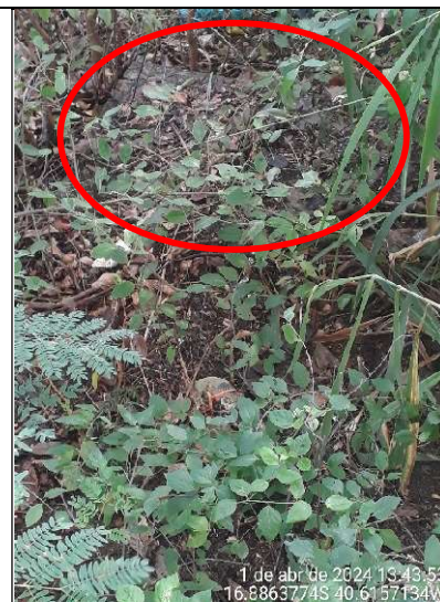
Figura 64 - Detalhe da tampa da fossa negra
