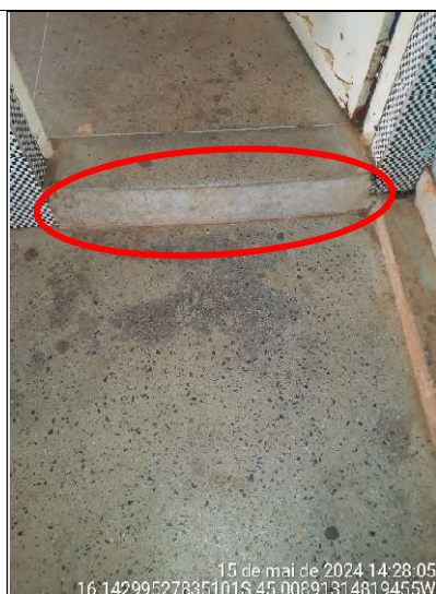
Figura 206 - Detalhe do desnível para acesso à sala de aula
