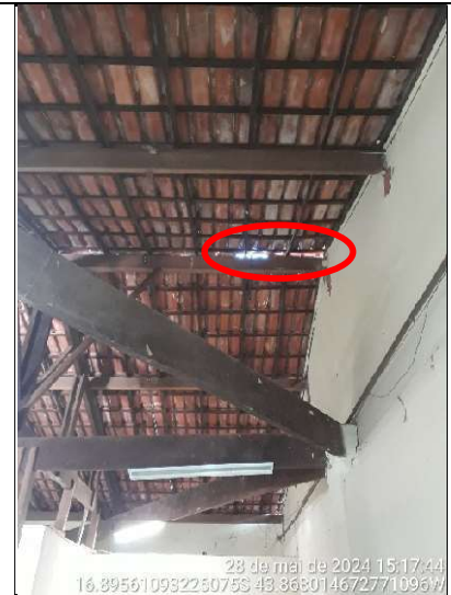
Figura 154 - Detalhe de frestas de luz na cumeeira da cobertura
