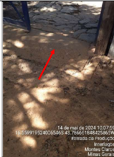
Figura 105 - Detalhe da rampa de acesso à parte interna da escola
