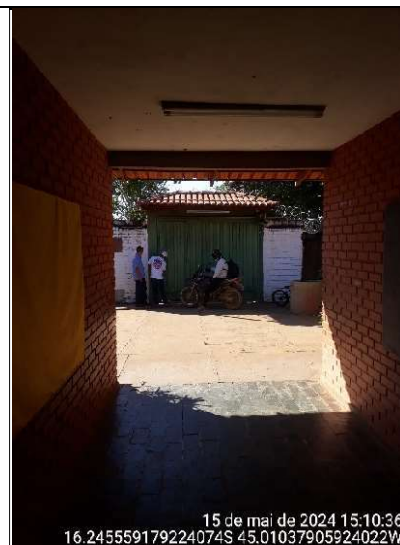
Figura 226 - Detalhe da vista interna da entrada da escola
