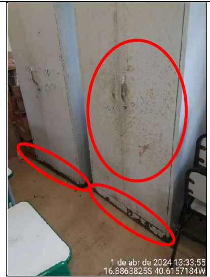
Figura 55 - Detalhe de ferrugens nos armários
