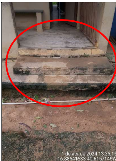
Figura 42 - Detalhe da escada de acesso à escola
