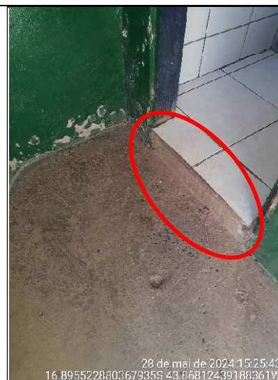
Figura 145 - Detalhe de desnível para acesso ao banheiro feminino
