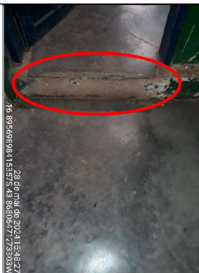
Figura 144 - Detalhe do desnível para acesso à sala de aula
