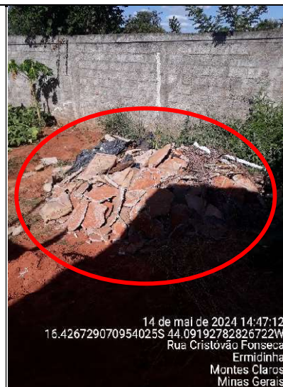
Figura 82 - Detalhe de resíduos da reforma e ampliação
