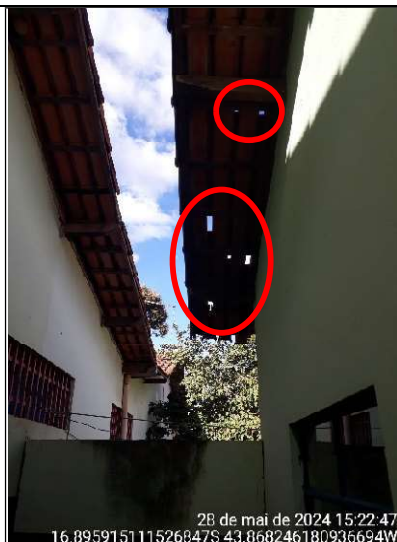
Figura 155 – Detalhes de frestas de luz no beiral da cobertura
