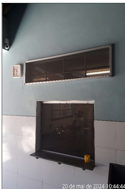
Figura 449 – Detalhe da tela nas janelas e vãos da cozinha
