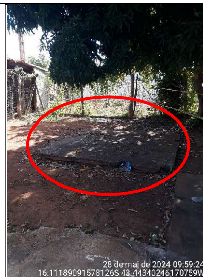
Figura 445 - Detalhe da tampa da fossa negra
