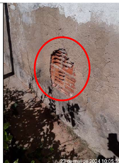
Figura 388 – Detalhe de trecho da parede sem revestimento
