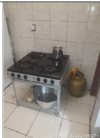
Figura 283 – Detalhe do botijão de GLP no fogão
