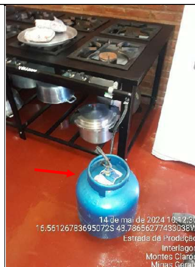
Figura 133 – Detalhe do botijão de GLP no fogão
