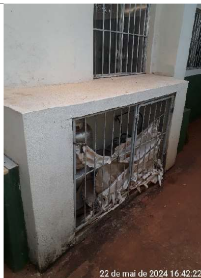
Figura 324 – Detalhe da casa de gás
