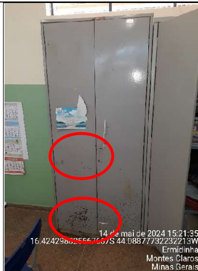
Figura 101 - Detalhe de ferrugem em armário
