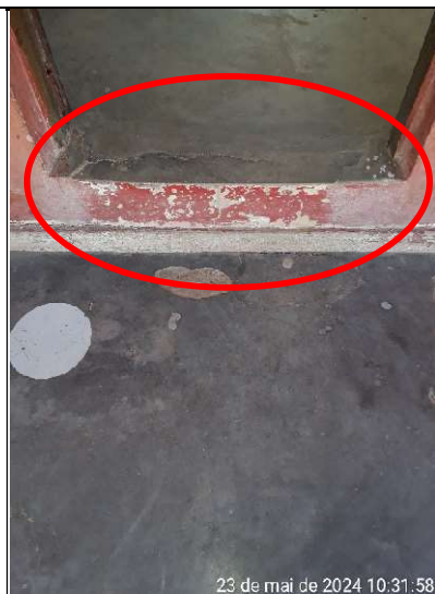
Figura 383 – Detalhe do desnível para acesso à sala de aula
