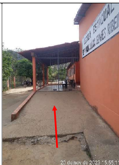
Figura 3 – Vista frontal da rampa de acesso à escola
