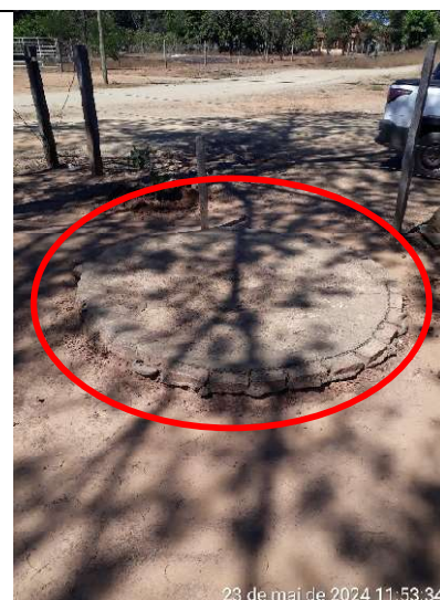
Figura 376 – Detalhe da tampa da fossa negra
