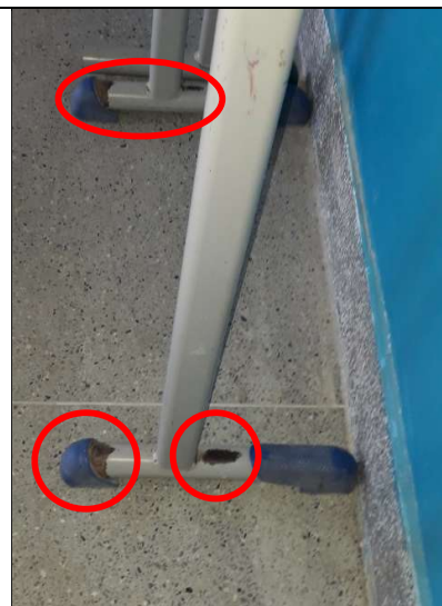
Figura 340 – Detalhe de ferrugem nas mesas das sala de aula
