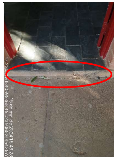
Figura 232 - Detalhe de desnível para acesso à sala de aula
