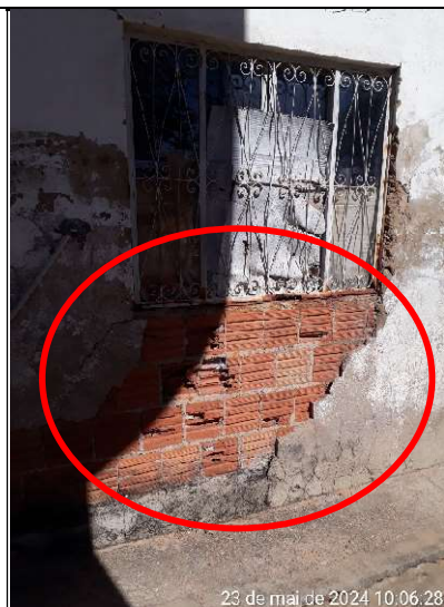
Figura 389 – Detalhe de trecho da parede sem revestimento
