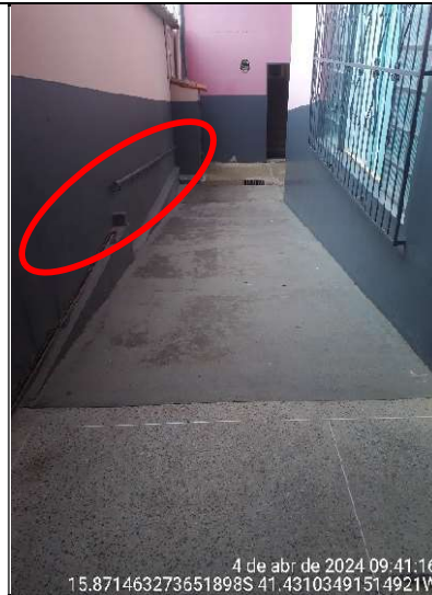
Figura 66 - Detalhe do corrimão em apenas um lado da rampa e com dimensão linear menor que a rampa
