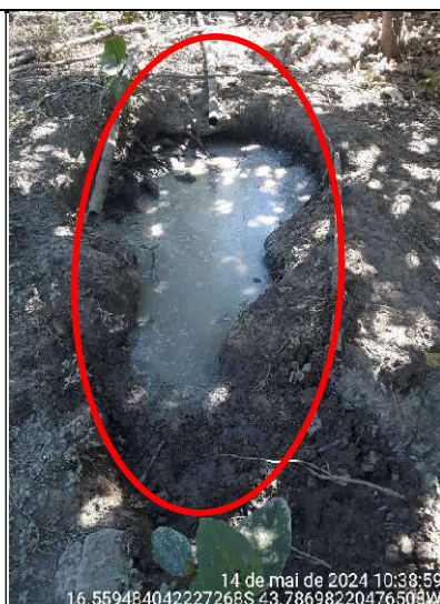
Figura 132 – Detalhe do lançamento do efluente de esgoto da cozinha diretamente no solo, devido à ausência de caixa de gordura
