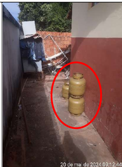
Figura 282 – Detalhe do local de armazenamento de botijões de GLP, em local descoberto
