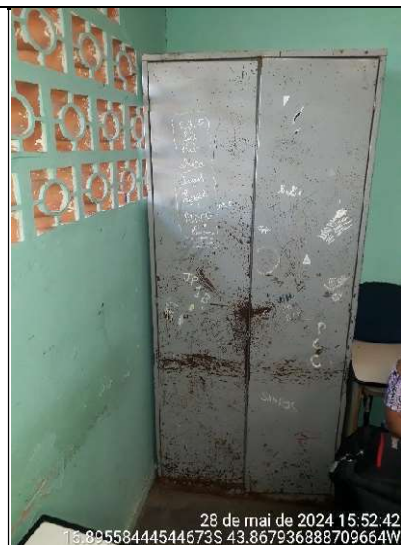
Figura 158 – Detalhe de armário com ferrugem
