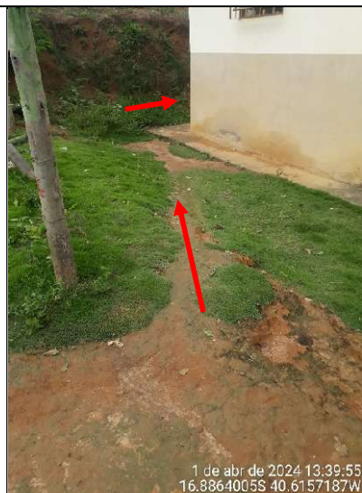
Figura 41 - Detalhe do caminho a ser percorrido para a escada de acesso à escola
