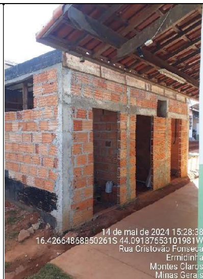
Figura 86 - Detalhe da ampliação da escola (bloco novo)
