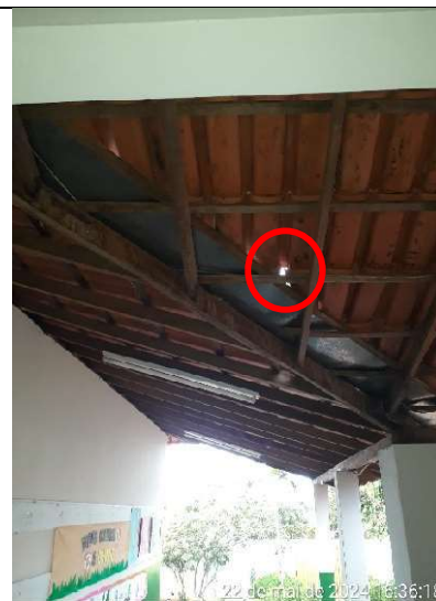
Figura 316 – Detalhe de fresta de luz na cobertura
