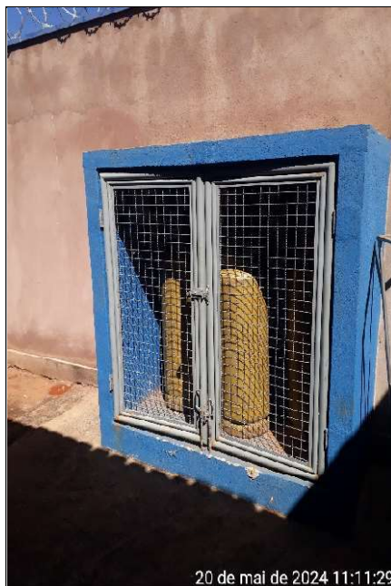
Figura 452 – Detalhe da casa de gás
