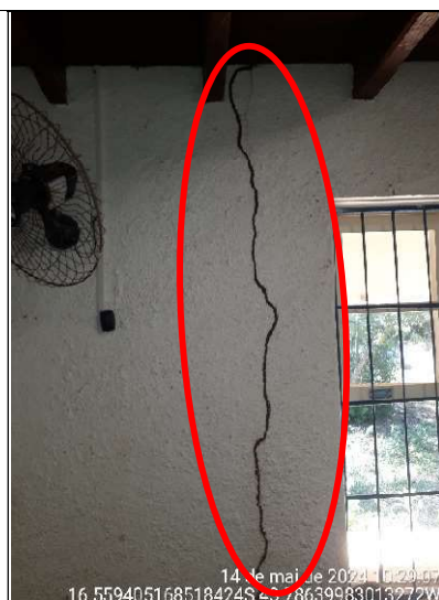
Figura 114 - Detalhe de caminho de cupim na parede da sala de aula
