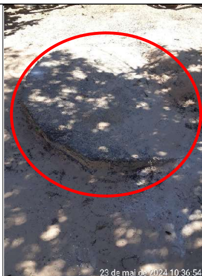
Figura 417 – Detalhe da tampa da fossa negra
