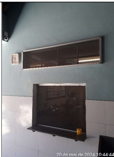
Figura 300 – Detalhes das telas nas janelas e vãos da cozinha
