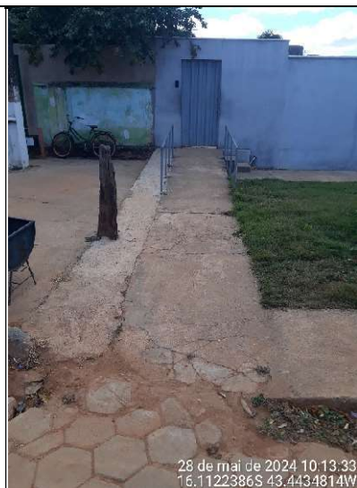
Figura 419 – Detalhe da rampa lateral de acesso à escola
