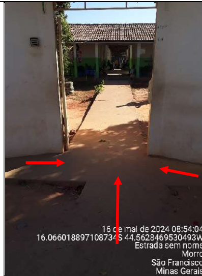
Figura 174 - Detalhes das rampas de acesso à escola
