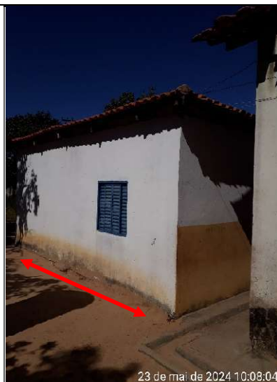
Figura 384 – Detalhe de trecho sem calçada
