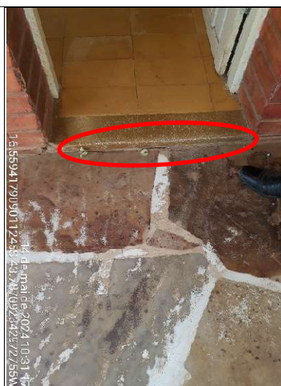
Figura 113 - Detalhe de desnível para acesso à sala de aula
