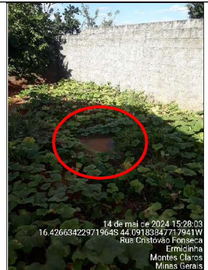
Figura 103 - Detalhe da tampa da fossa negra
