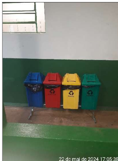
Figura 457 – Detalhe de coletores individuais da coleta seletiva
