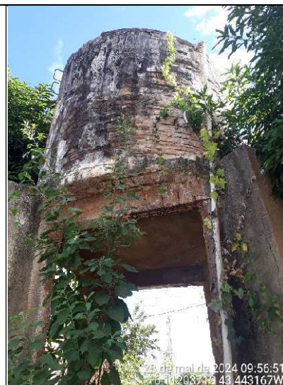
Figura 446 - Detalhe da caixa d'água antiga localizada no fundo da escola
