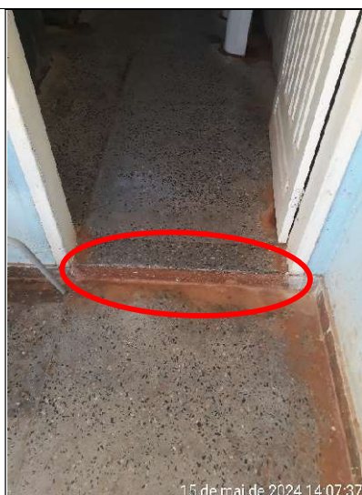
Figura 207 - Detalhe do desnível para acesso ao banheiro feminino
