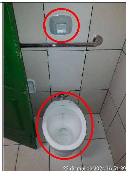
Figura 320 – Detalhes das ausências de metal para acionamento da válvula de descarga para PcD e de assento na bacia sanitária
