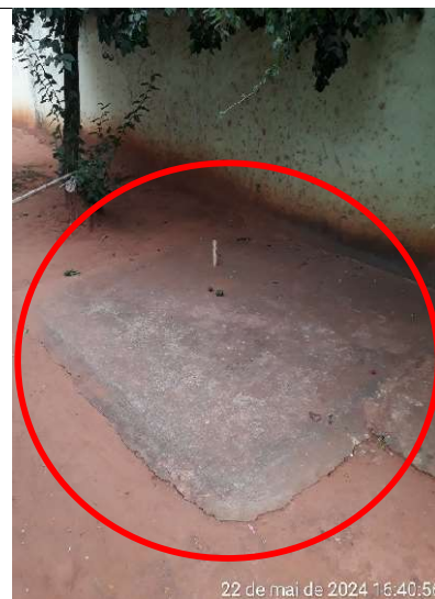
Figura 325 – Detalhe da tampa da fossa negra
