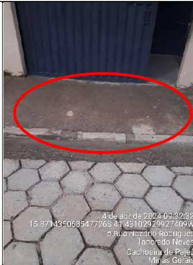
Figura 65 - Detalhe da calçada de acesso à escola, lado externo
