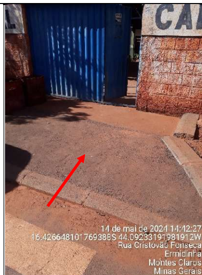
Figura 80 - Detalhes da rampa e calçada de acesso à escola, lado externo
