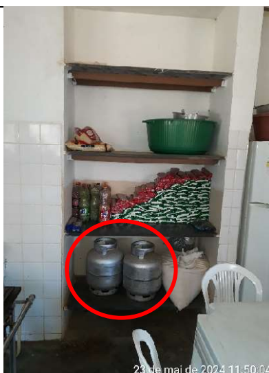
Figura 375 – Detalhe do armazenamento de botijões reservas de GLP dentro da cozinha
