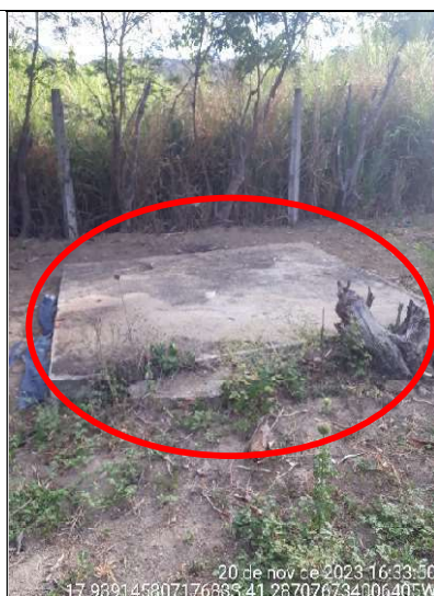
Figura 12 - Detalhe da tampa da fossa negra
