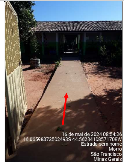
Figura 175 - Detalhe da calçada de acesso à escola, logo após a rampa
