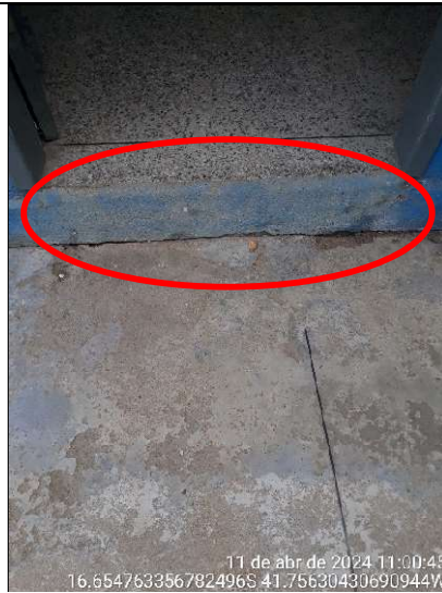
Figura 40 - Detalhe do desnível para acesso à sala de aula
