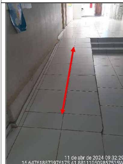
Figura 6 - Detalhe de rampa interna com piso cerâmico liso
