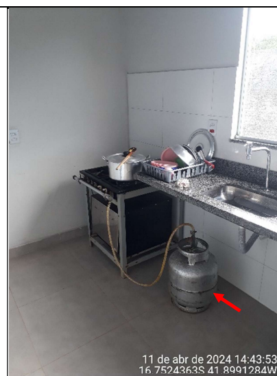
Figura 26 - Detalhe de botijão de GLP na cozinha
