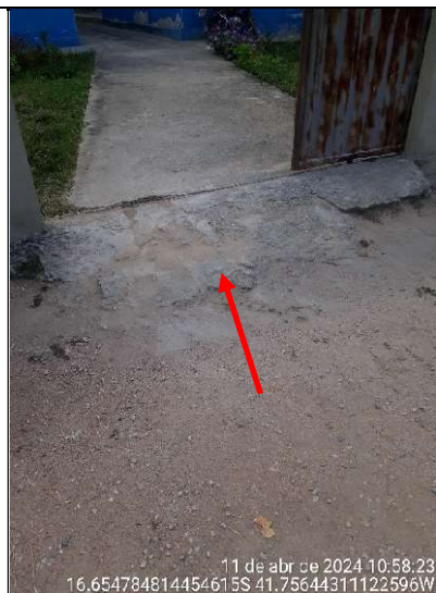
Figura 27 - Detalhe da rampa de acesso à escola
