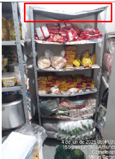
Figura 64 – Detalhe do mau estado de conservação do armário de armazenamento de alimentos
