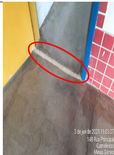
Figura 32 - Detalhe do desnível para acesso à sala de aula
