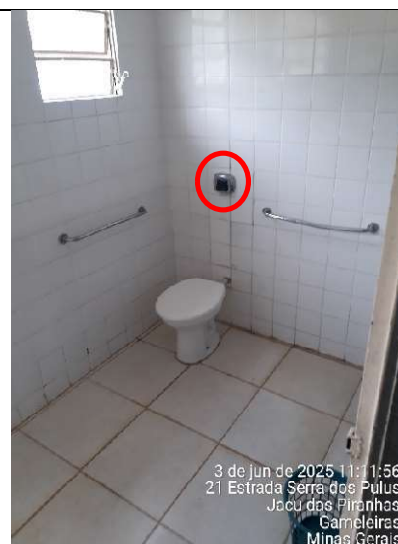
Figura 20 – Detalhe da válvula de descarga no box para PcD
