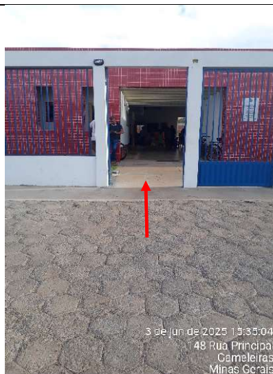
Figura 28 - Detalhe do pavimento e calçada de acesso principal às unidades escolares
